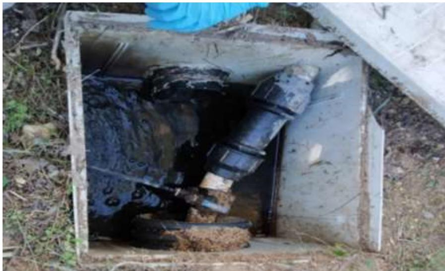
**Figura 32.** Salida del sistema de depuración. Arqueta (A6) en la parcela C, conducción hacia el barranco y la Humedal artificial de flujo superficial. Fuente: Elaboración propia
