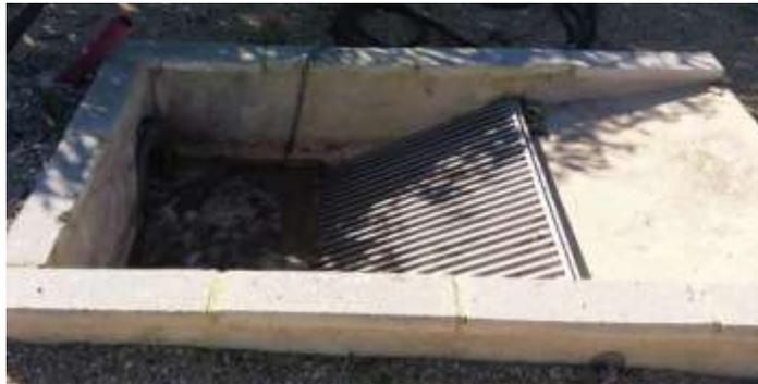
Figura 19. Canal de desbaste. Fuente: Elaboración propia
