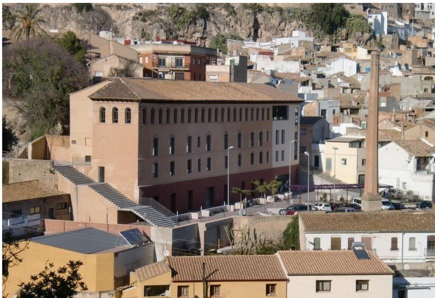
**TIPO 4.** Fábricas Modernas formadas por la agrupación de naves rectangulares de estructura metálica y cubierta resuelta a dos aguas. Aunque incluimos el Molino Cachorro en esta tipología, lo único que coincide, es la fecha de construcción, ya que los sistemas constructivos y la forma del edificio no se ajusta a ninguna de las tipologías anteriores.
