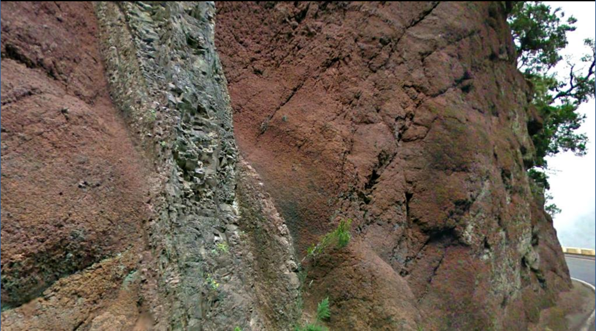
Dique subvertical atravesando coladas de piroclastos del Mio-Plioceno, Terciario. Carretera del Bailadero, E de La Cumbrilla, N Tenerife. E Hoja de Tejina.
