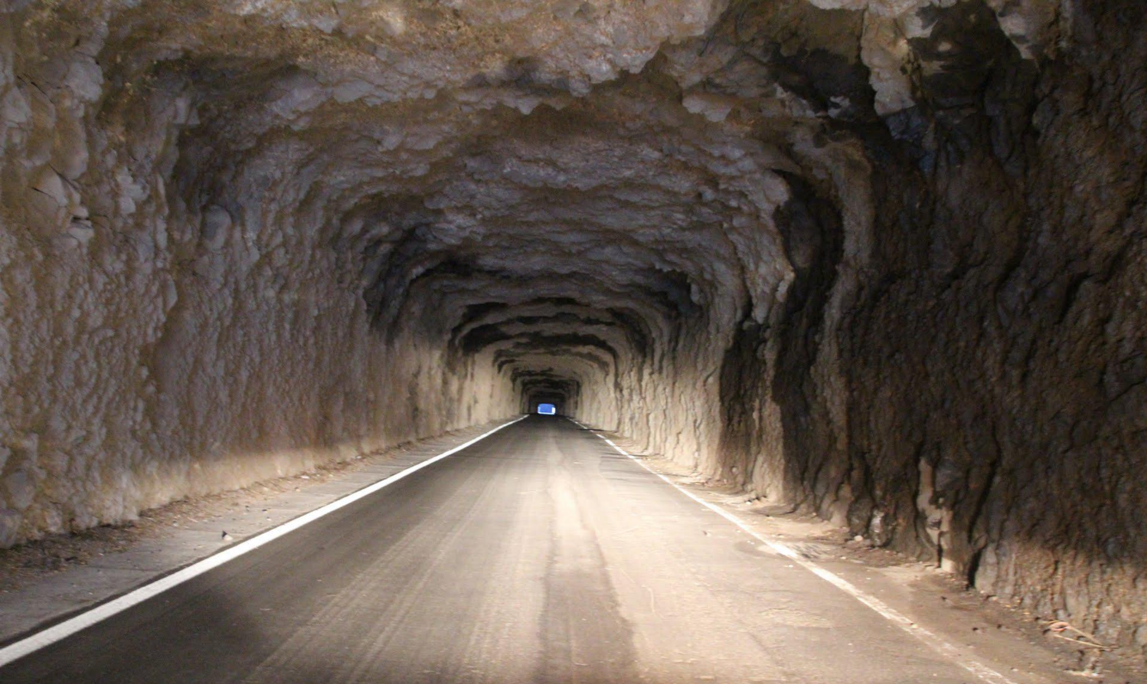
Túnel sin revestimiento en la zona de basaltos y traquibasaltos del Mio-Plioceno. Acceso desde el W a Buenavista del Norte. SE Hoja de Punta Teno. NW Tenerife. (por Tomasz Bukowski-Google)
