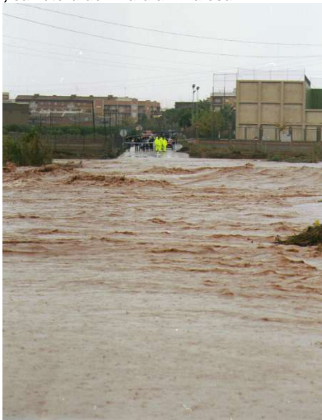
Fotografía 1.1.2. Desbordamiento del barranco en el 2000. Vista transversal, carretera de Alfara a Vinalesa.
