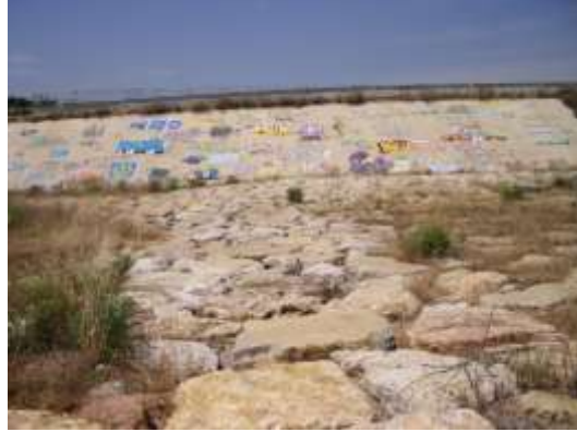
Fotografía 3.3.6. Zona de bloques de piedras.
