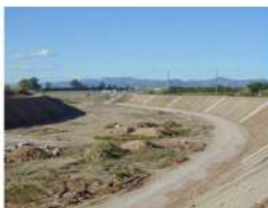
Imagen 11.4. Obras de encauzamiento del Barranco del Carraixet
