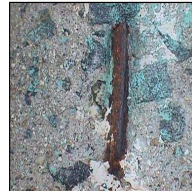
**Figura 5.** Armadura sometida a un ataque por sulfatos
