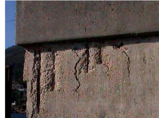
**Figura 27.** Desconchados del hormigón, fisuración inducida por la corrosión de la armadura
