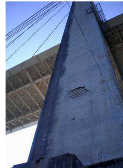
**Figura 29.** Efectos de la corrosión sobre un puente de hormigón armado
