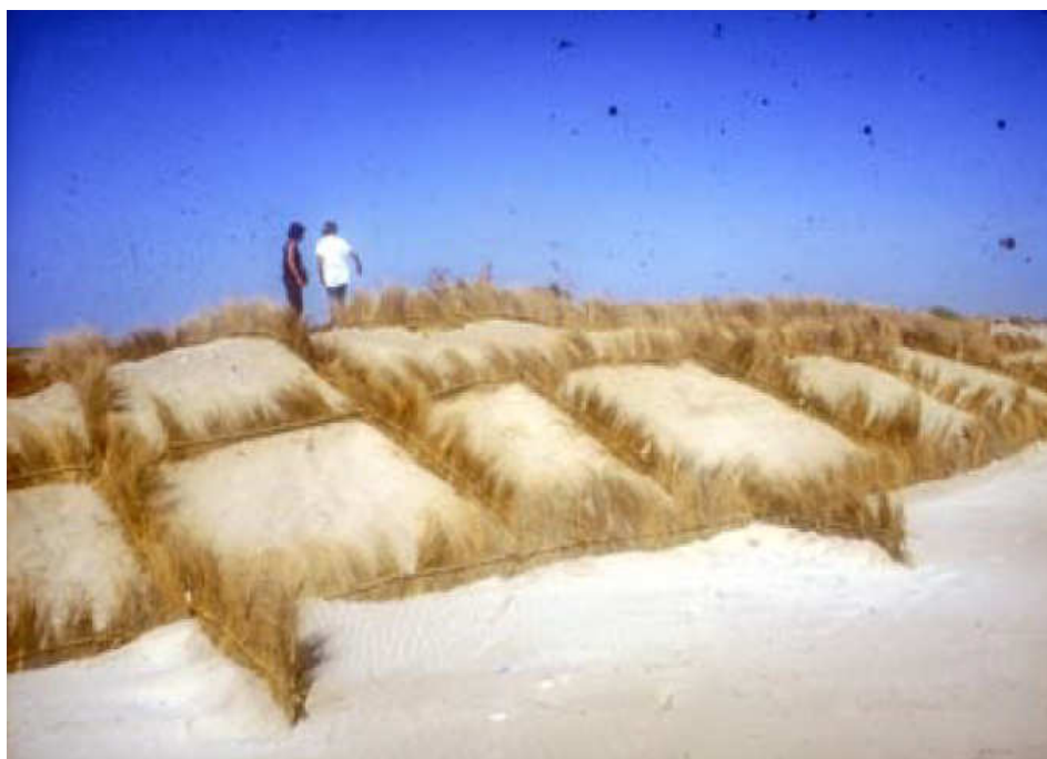
Imagen 20. Foto sistema de empalizadas en la restauración de las dunas litorales de la Devesa (Albufera de Valencia). Ayuntamiento de Valencia-Devesa L'Albufera.
