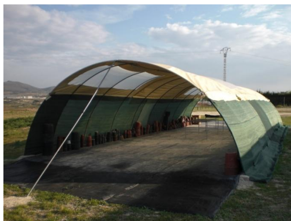
Figura 3.4 Magatzem i zona de treball.
