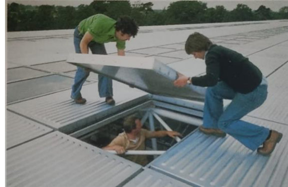
FIG. 15. PANEL DE CUBIERTA DESMONTADO PARA MANTENIMIENTO
