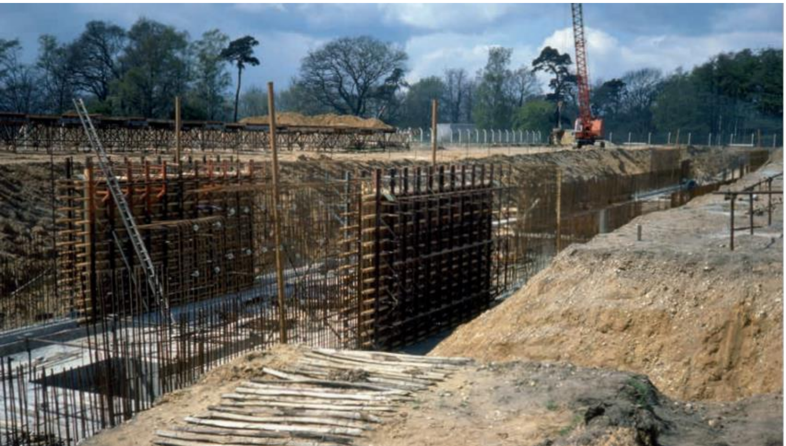
FIG. 37. COLOCACIÓN DE LOS ENCOFRADOS PARA LA CONSTRUCCIÓN DEL SÓTANO DE HORMIGÓN ARMADO
