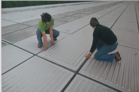
FIG. 16. PANEL DE CUBIERTA COLOCADO.
