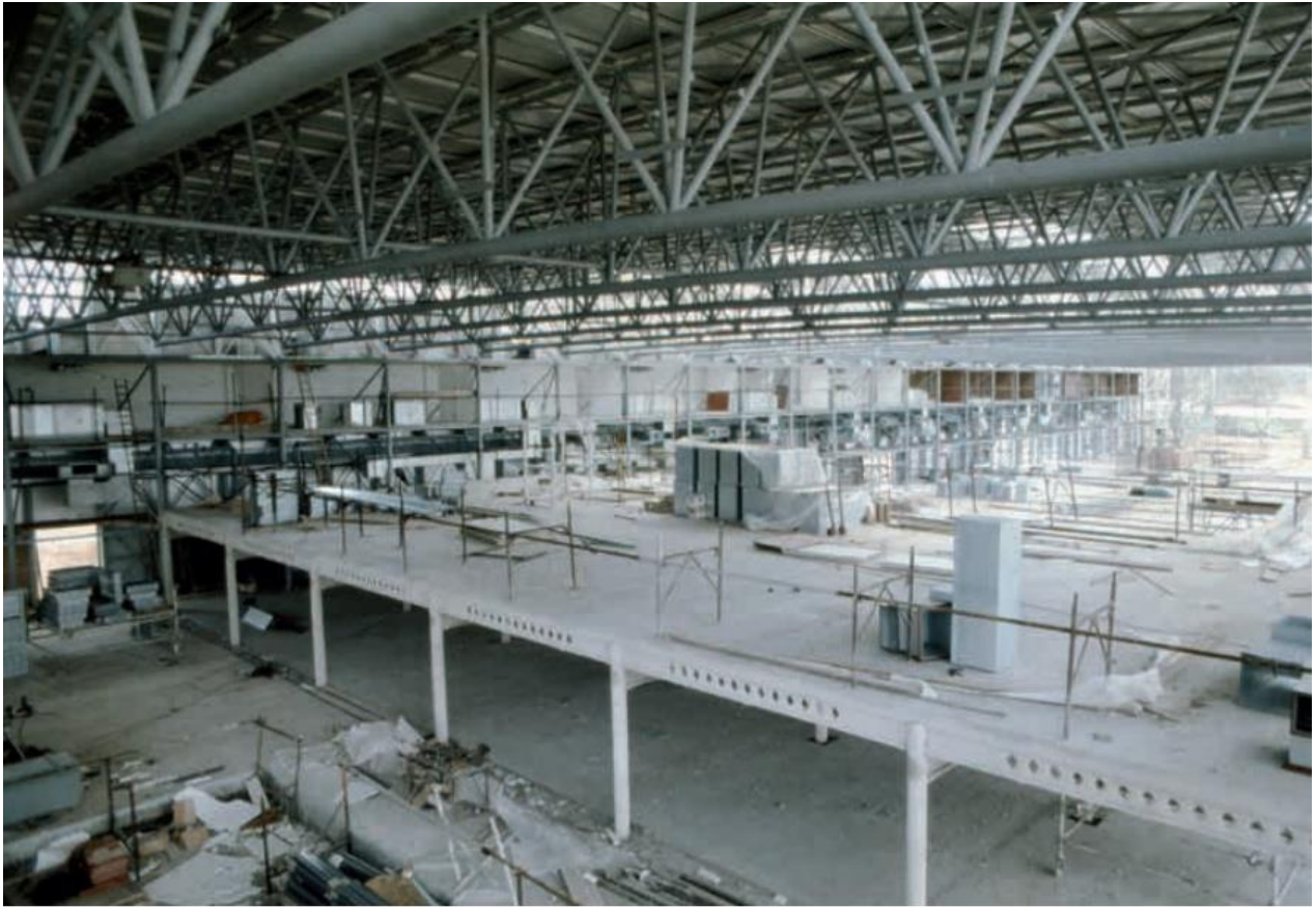
FIG. 40. ESTRUCTURA DE CUBIERTA Y ESTRUCTURA SECUNDARIA INTERIOR
