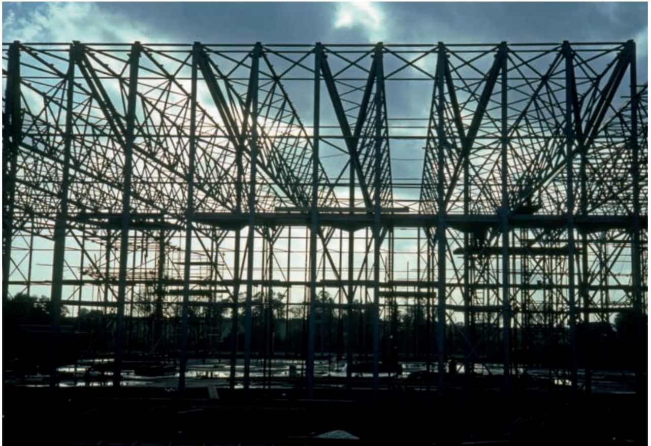
FIG. 39. ESQUELETO DEL EDIFICIO DONDE SE APRECIA TAMBIÉN LA VIGA CONTRAVIENTO
