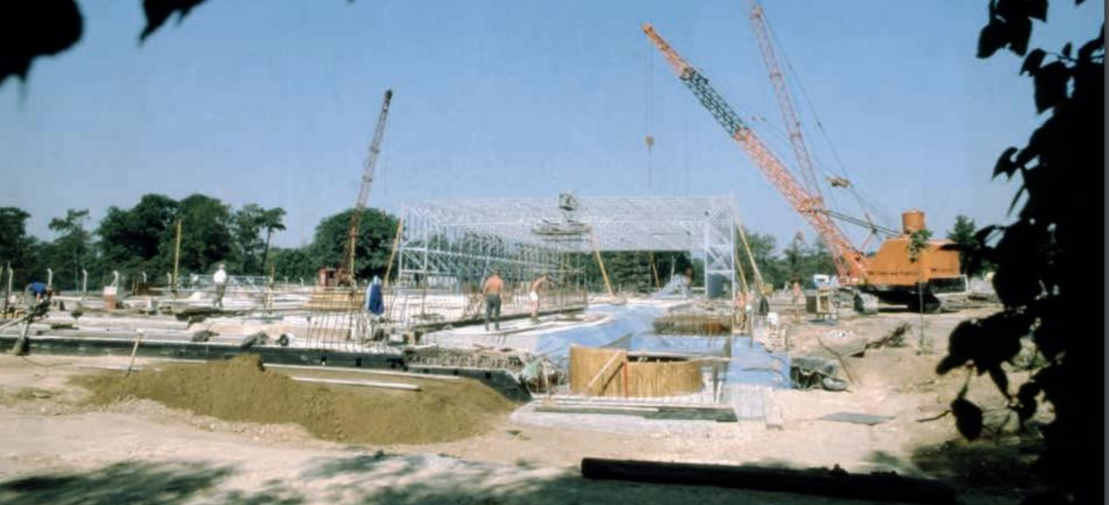
FIG. 35. FOTOGRAFÍA TOMADA DURANTE LA CONSTRUCCIÓN DE LA ESTRUCTURA DEL SAINSBURY CENTRE
