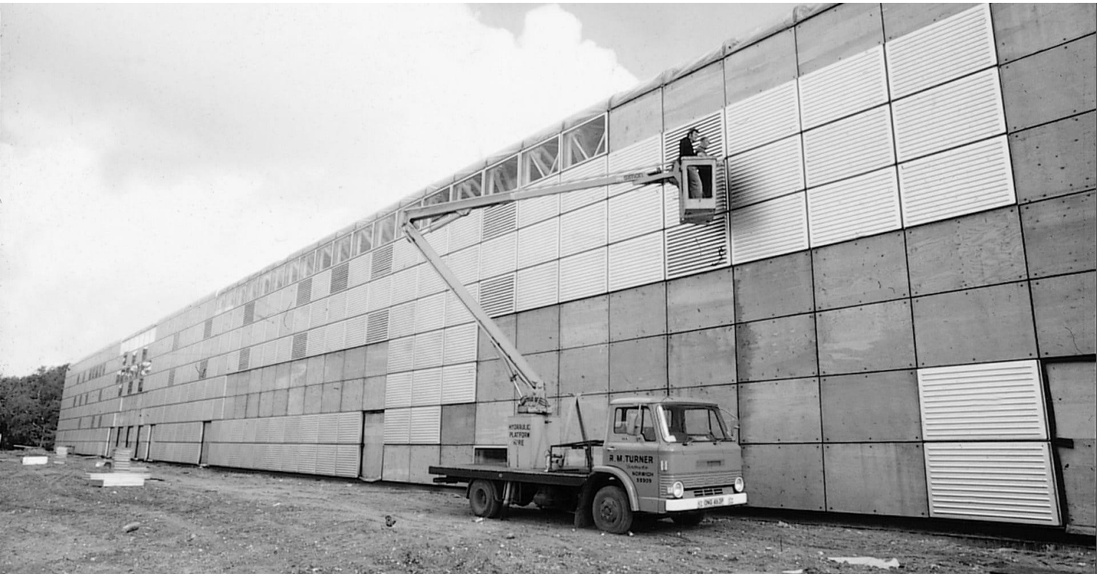
FIG. 38 COLOCACIÓN DE LOS PANELES DE REVESTIMIENTO EXTERIOR
