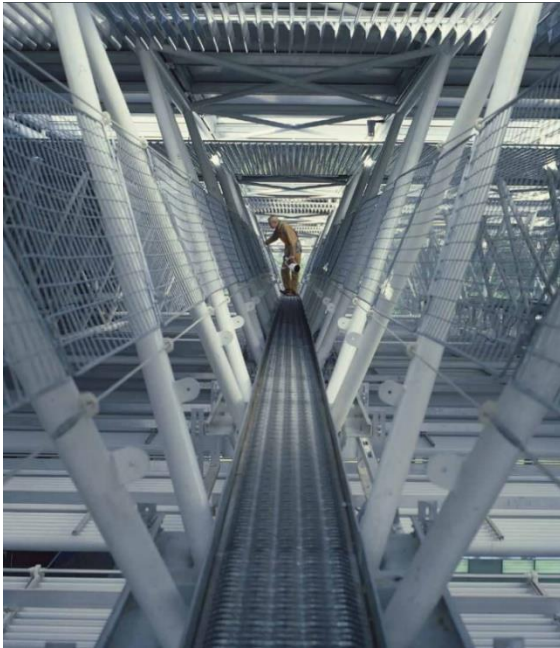
FIG. 68. FOTOGRAFÍA DEL INTERIOR DE UNA DE LAS CELOSÍAS DE CUBIERTA
