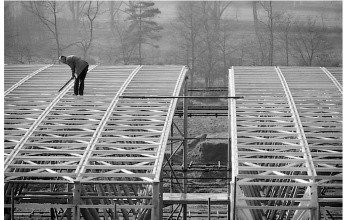
FIG. 26. FOTOGRAFÍA TOMADA DURANTE SU CONSTRUCCIÓN DONDE SE APRECIA LA LIGERA CURVATURA DE LA CELOSÍA TRIDIMENSIONAL DE CUBIERTA
