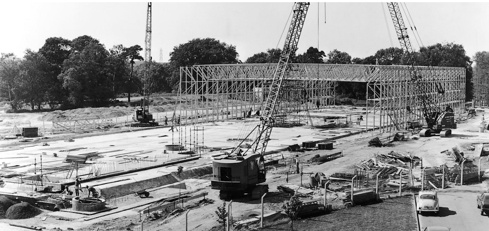
FIG. 34. FOTOGRAFÍA TOMADA DURANTE LA CONSTRUCCIÓN DE LA ESTRUCTURA DEL SAINSBURY CENTRE
