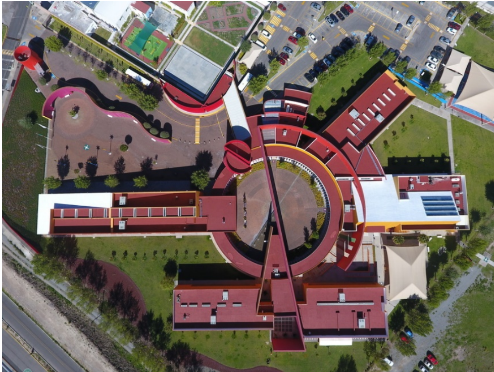
Ilustración 38. Cubierta impermeabilizada con Imperllanta.
