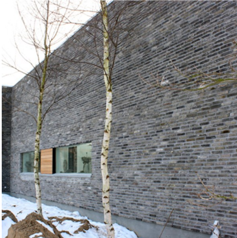
Ilustración 32. Casa Tove exterior
