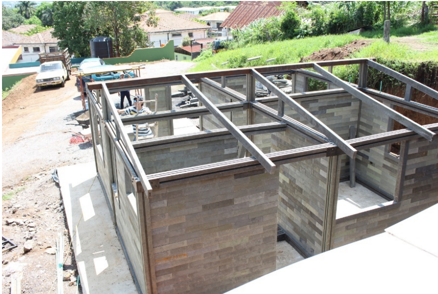
Ilustración 47. Ejemplo de vivienda en construcción ladrillos PET
