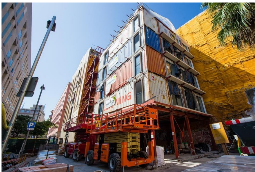
Ilustración 23. Edificio APROP, Barcelona acabado
