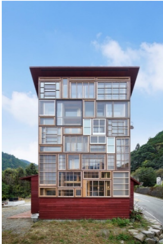
Ilustración 27. Fachada ventanas casa pública Kamikatz.
