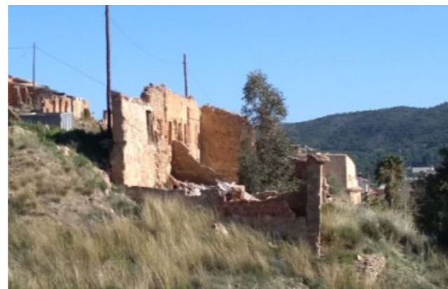
Figura 84. Fachada Norte.Pajar P-8. Fuente: Visita de campo. Febrero 2020.
