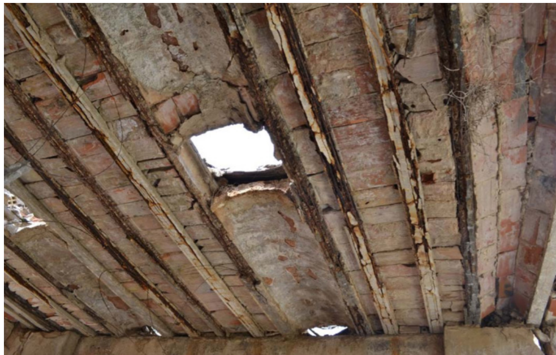
Figura 32. Tabique de lajas y yeso en Gestalgar (Arriba derecha). Fuente: Estudio del yeso tradicional en España, Fotografía de C. J. Grau y V. La Spina, 2016.
