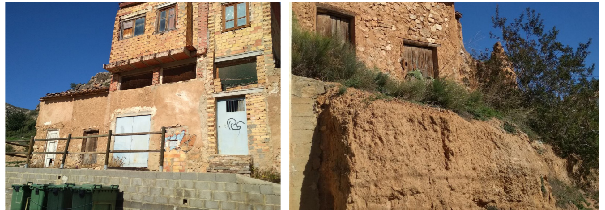
Figura 113. Fotografía de los pajares situados en la Calle Calvario, donde el acceso se produce por una rampa. Fuente: Visita de campo. Febrero 2020.
