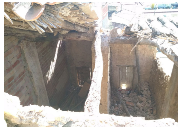
Figura 100. Fachada Sur. Fuente: Visita de campo. Febrero 2020.
