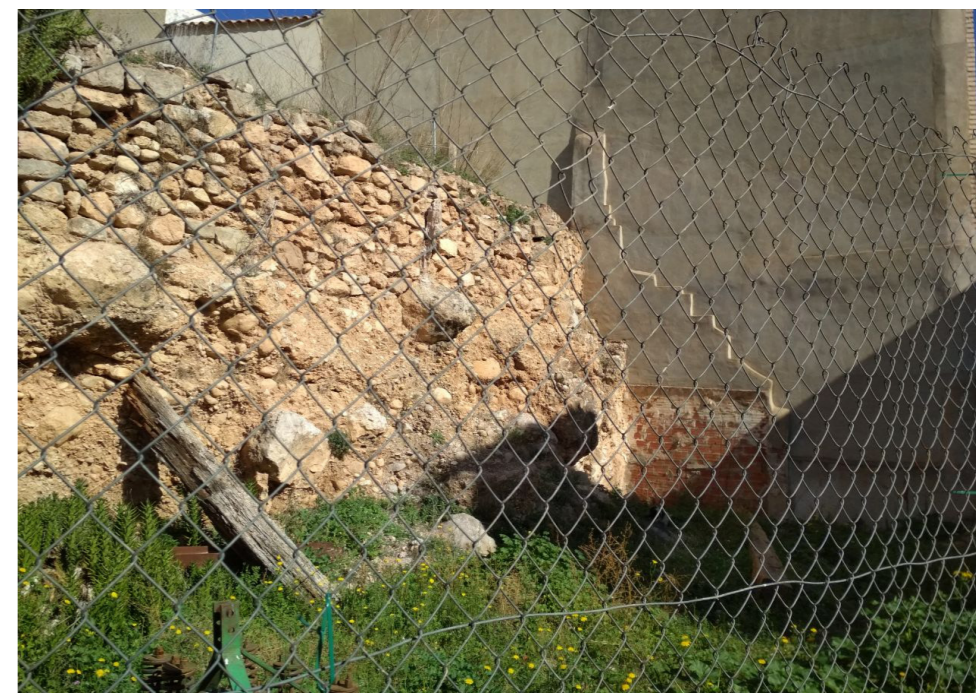
Figura 72. Muro de mampostería, cimentación del pajar.
