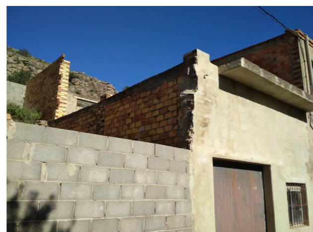
Figura 58. Estado actual del pajar P-1. Fuente: Visita de campo. Febrero 2020.
