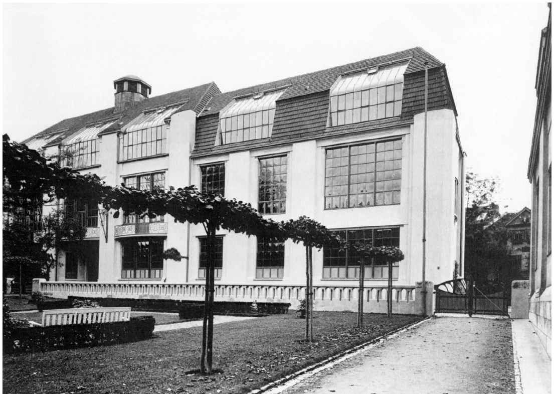
Edificio de la Escuela de Arte de Weimar.
