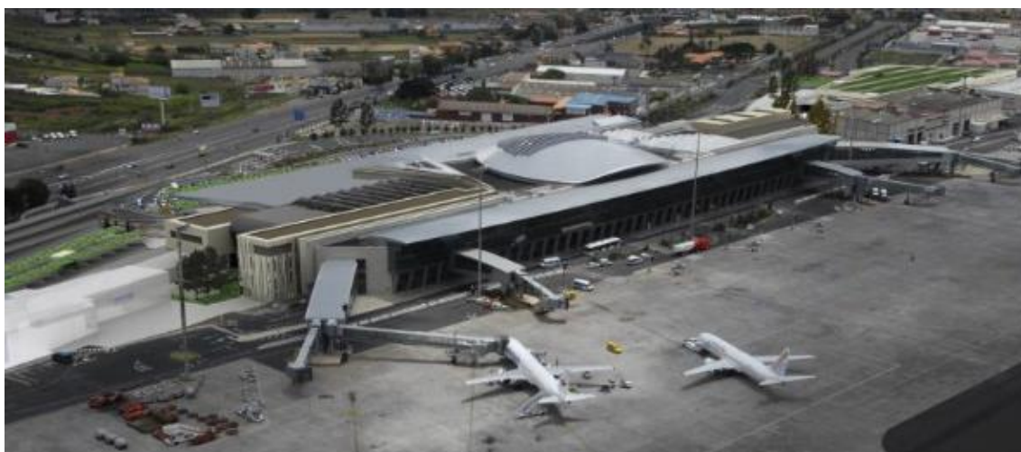
Figura 5. Estado actual TFN. http://www.infraestructurasytransporte.sener
