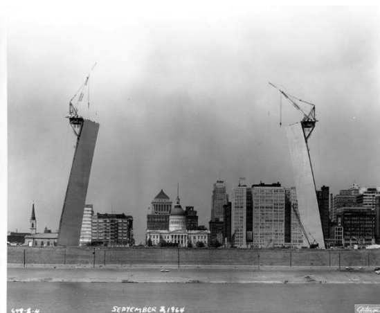
Figuras 43 y 44: Ejecución del arco mediante grúas trepadoras
