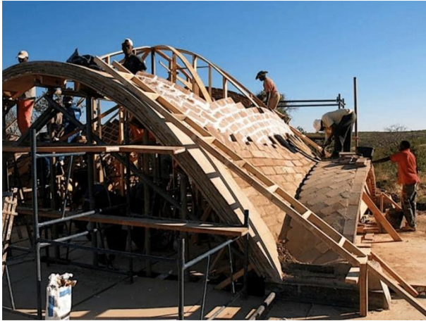
Figura 66: Construcción de las bóvedas sobre guías
