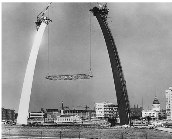
Figuras 45 y 46: Disposición de la pasarela de refuerzo entre las dos semiestructuras
