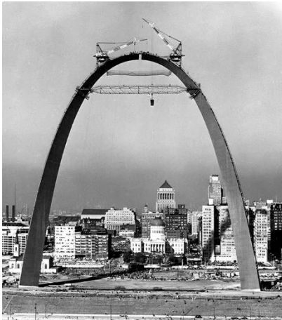
Figuras 47 y 48: Colocación del último segmento del arco
