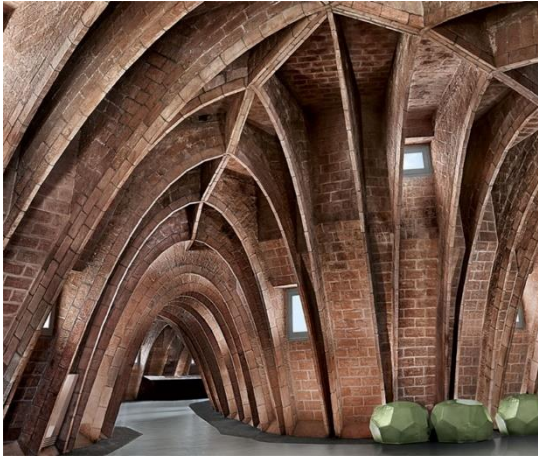
Figura 12: Galería de arcos catenarios de la casa Milà
