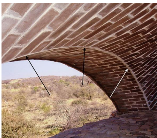
Figura 76: Reparación en el cambio de curvatura
