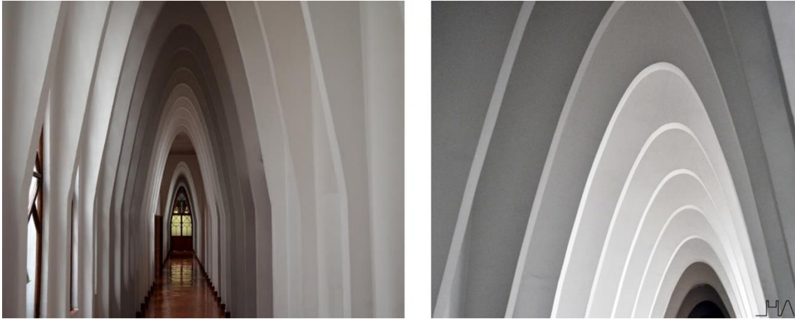
Figuras 14 y 15: Galería de arcos parabólicos del Colegio de las Teresianas
