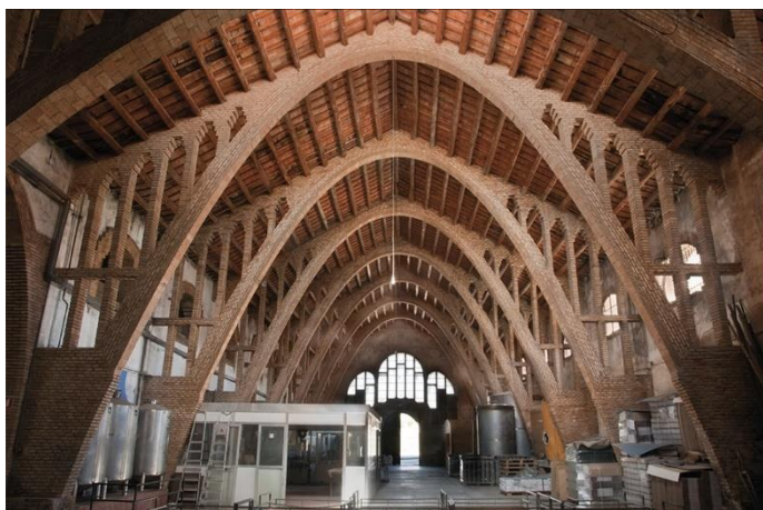
Figura 30: Interior del Sindicato de Trabajadores Agrícolas de Rocafort de Queralt
