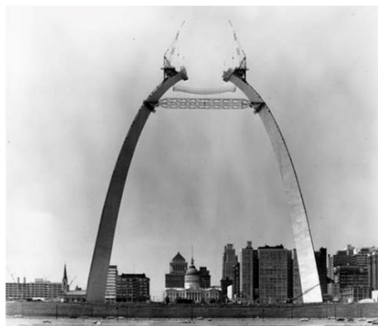
Figuras 45 y 46: Disposición de la pasarela de refuerzo entre las dos semiestructuras
