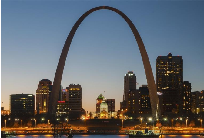
Figura 49: Gateway Arch completado
