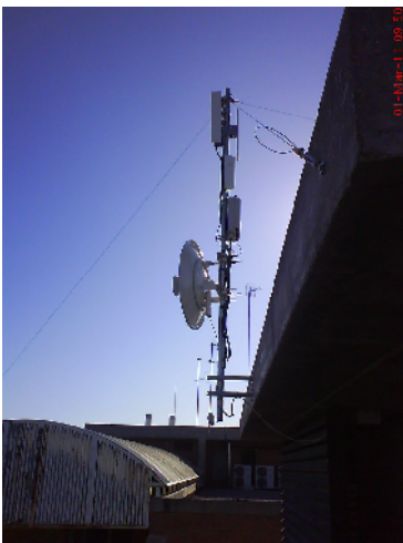
Figura 3.26. Fotografía de los tensores del mástil
