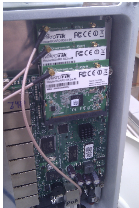
Figura 3.16. Fotografía colocación pigtails
