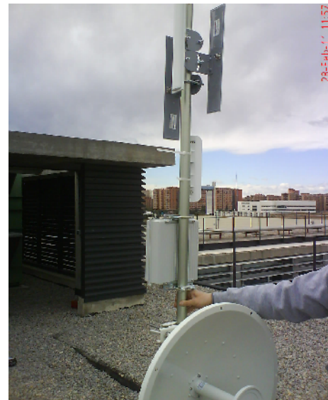
Figura 3.24. Fotografías de la colocación antenas y router en el mástil
