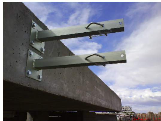
Figura 3.23. Fotografía y gráfico de los soportes del mástil
