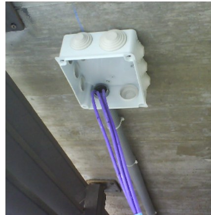
Figura 3.20. Fotografía roseta tejado
