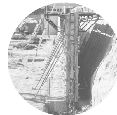
Detalle Muro de contención
