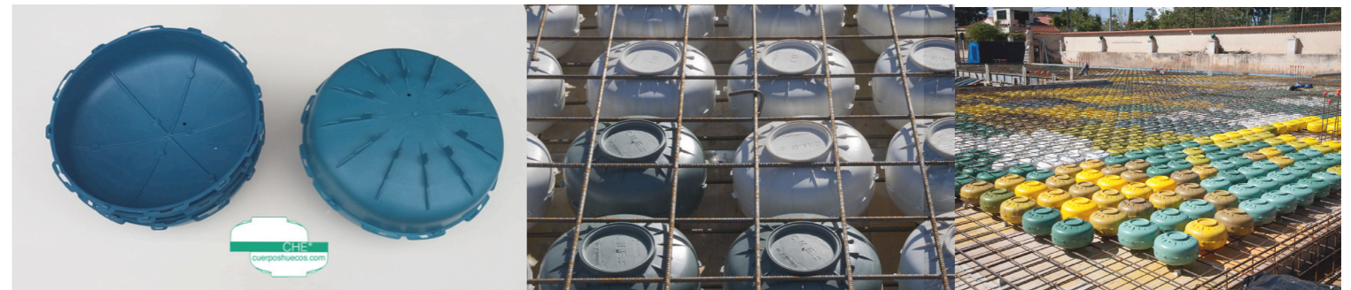
FORJADO SANITARIO TIPO CAVITI
