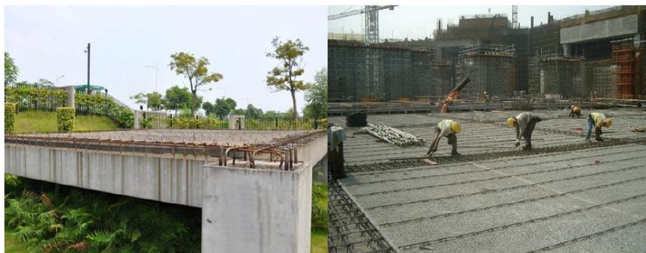
Imagen 34: Vaciado in situ para losas y vigas
