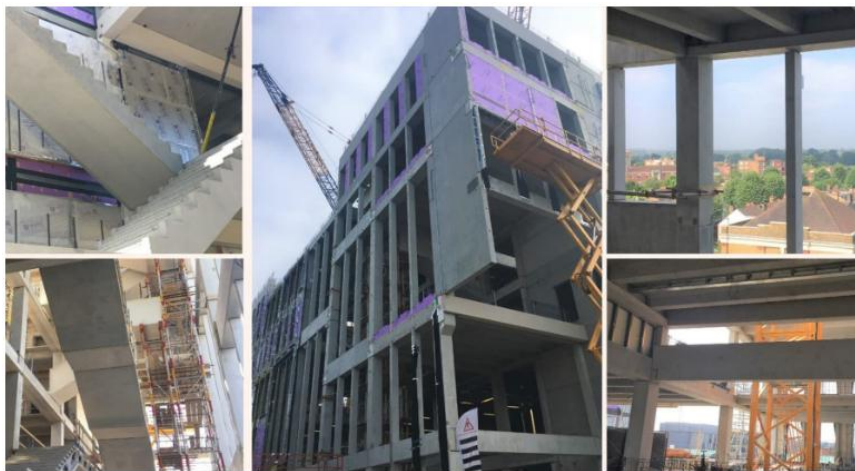
Imagen 10: Sistema esqueleto (Kingston University)
