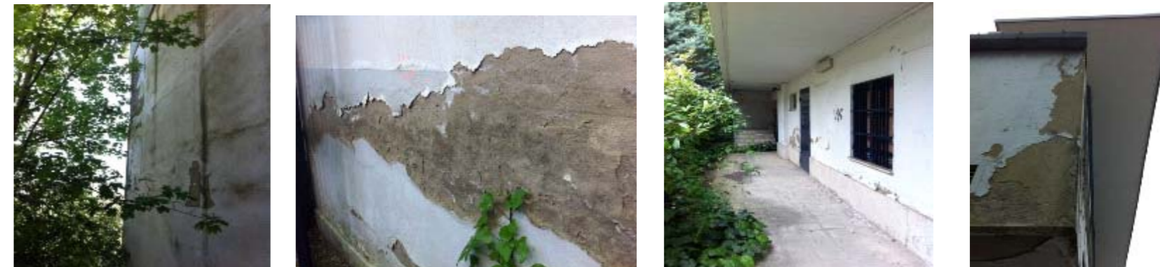
Fachada lateral izquierda. Humedad, patina biológica, fisuras, deterioro y desprendimiento del enlucido, grafitis. Facciata laterale sinistra. Umidità, patina biologica, fessurazione, degrado e distacco dell'intonaco, murali in vernice indelebile.
