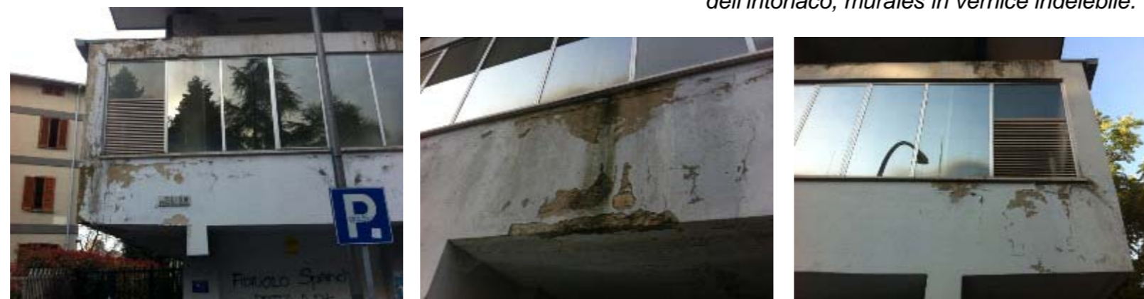
Fachada principal. Rotura del canalón, humedad, patina biológica, fisuras, deterioro y desprendimiento del enlucido, grafitis. Facciata principale. Rottura di grondaia, umidità, patina biologica, fessurazione, degrado e distacco dell'intonaco, murali in vernice indelebile.
