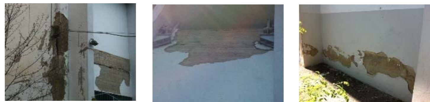
Fachada posterior. Humedad por capilaridad, fisuras, deterioro y desprendimiento del enlucido. Facciata posteriore. Umidità da risalita capillare, fessurazione, degrado e distacco dell'intonaco.
