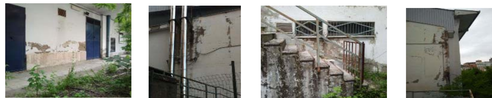
Fachada lateral derecha. Humedad, patina biológica, eflorescencias, fisuras, deterioro y desprendimiento del enlucido, oxidación de armaduras y desprendimiento del recubrimiento, grafitis. Facciata laterale destra. Umidità, patina biologica, efflorescenza, fessurazione, degrado e distacco dell'intonaco, degrado del ferro e disgregazione del copriferro, murali in vernice indelebile.
