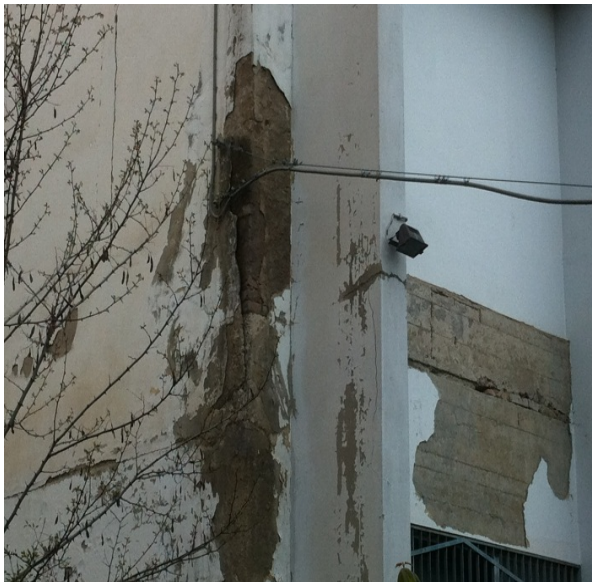
2.13 Distacco dell'intonaco
