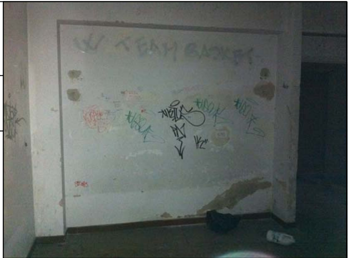
Distacco dell'intonaco, umidità da risalita capillare, murales in vernice indelebile.
