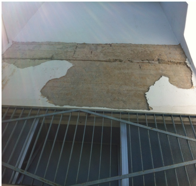
4.1 Rimozione dell'intonaco per guardare lo stato della parte strutturale.
