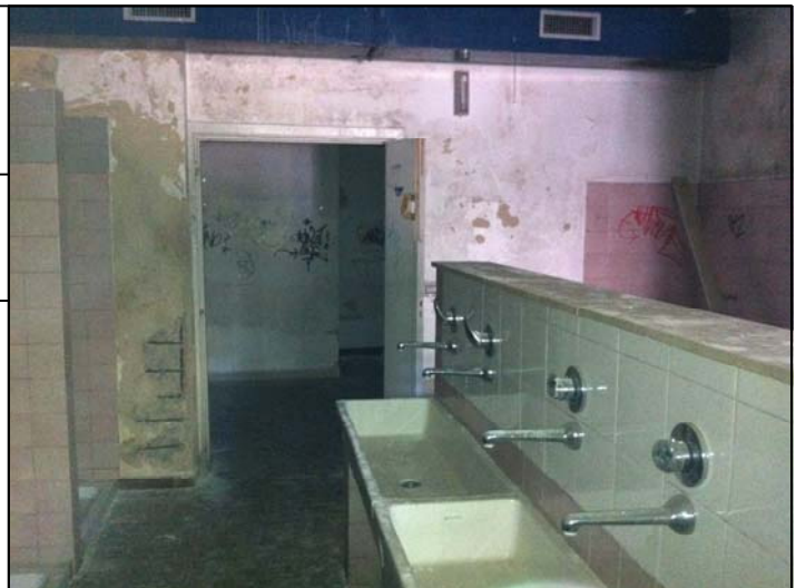
Degrado e distacco dell'intonaco, umidità da risalita capillare, murales in vernice indelebile, degrado del ferro e disgregazione del copriferro.
