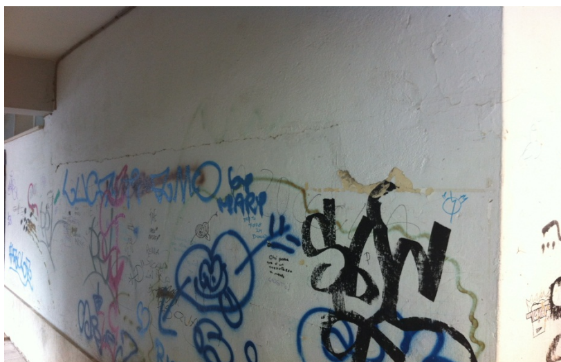
1.5 Degrado dell'intonaco, murales in vernice indelebile, umidità da risalita di calpestio
