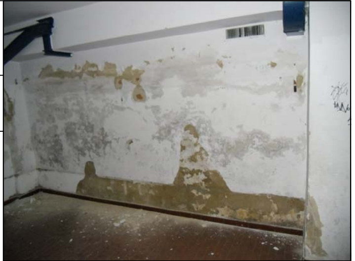
Degrado e distacco dell'intonaco, umidità da risalita capillare.
