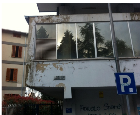
1.1 Distacco d'intonaco
