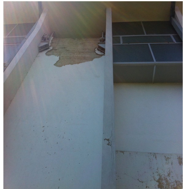
4.2 Rimozione dell'intonaco per guardare lo stato della parte strutturale.
