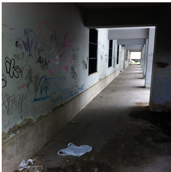
1.5 Degrado dell'intonaco, murales in vernice indelebile, umidità da risalita di calpestio
