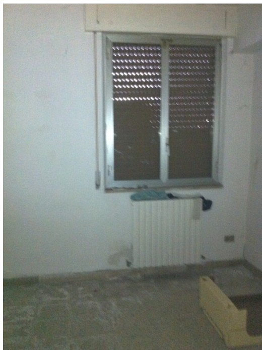
19 Camera. Efflorescenze sul pavimento.
