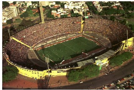
Figura 19. Estadio después de la ampliación de 1954
