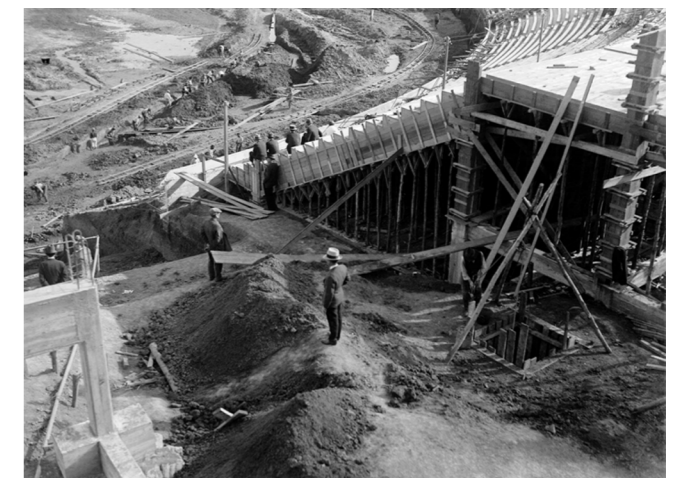
Figura 46. Construcción de una de las tribunas
