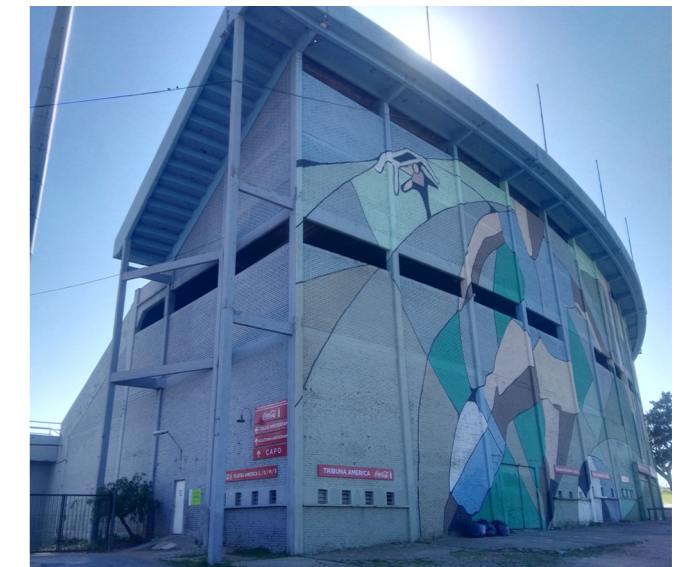
Figura 27. Exterior del estadio
