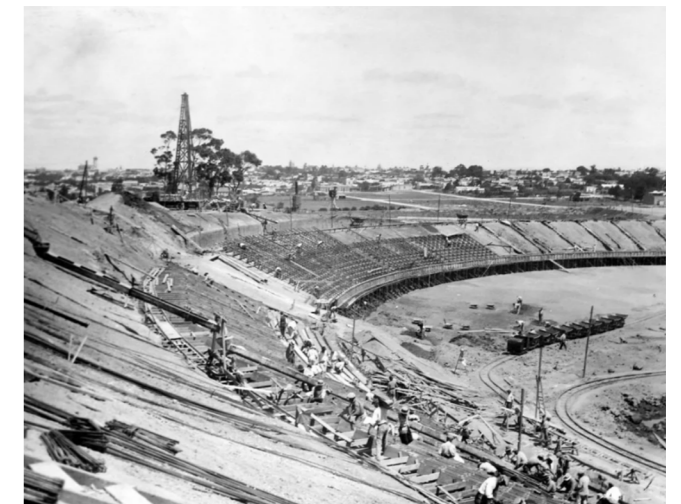
Figura 16. Construcción del estadio
