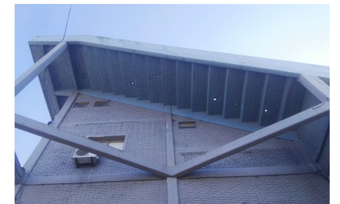
Figura 28. estructura del estadio
