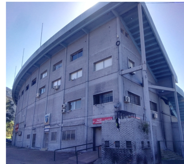
Figura 26. Exterior del estadio
