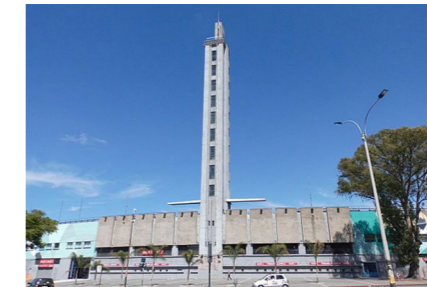
Figura 23. Construcción del ascensor en la Torre de los Homenajes
