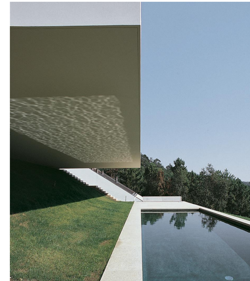
Fig. 41 Zona inferior y exterior de la Casa Horizontal
