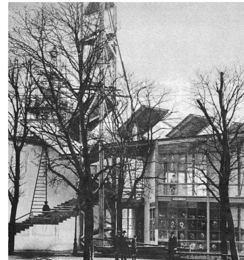
Fig. 11 Vista Sur del Pabellón con la torre
