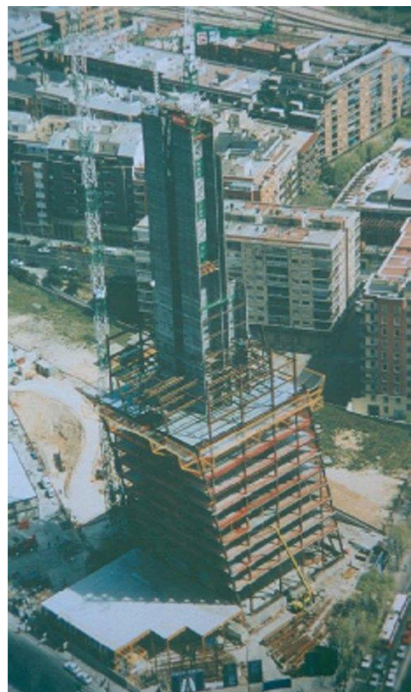
Fig.68 Vista aérea proceso de construcción
