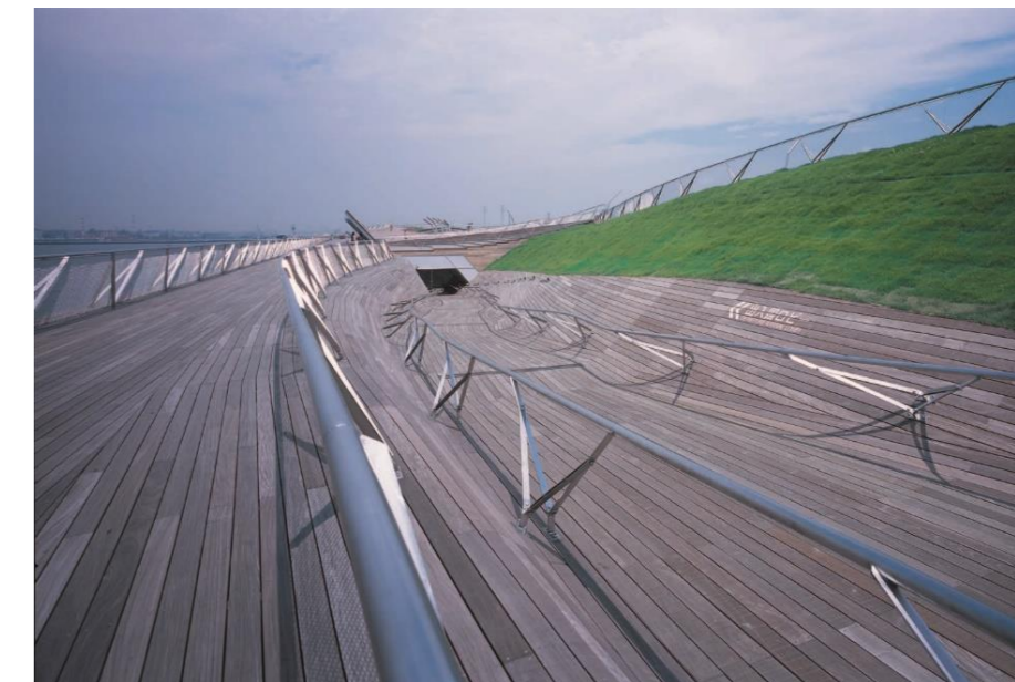
Fig. 34 Espacio de circulación exterior 2
