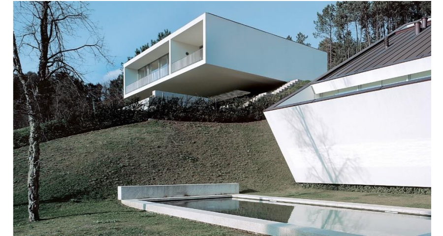
Fig. 38 Vista de las dos viviendas
