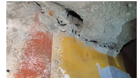
Fig. 6.5 Restos de una carpintería de madera dentro de las ruinas de la basílica Noniana (@ercolanoscavi, 2020)
