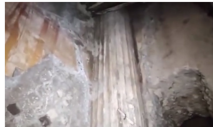
Fig. 6.7 Una columna de la basílica Noniana desde dentro de uno de los túneles de excavación (@ercolanoscavi, 2020)
