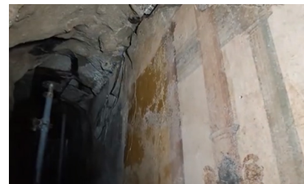
Fig. 6.1.12 Imagen desde dentro de uno de los túneles de excavación de la basílica Noniana (@ercolanoscavi, 2020)
