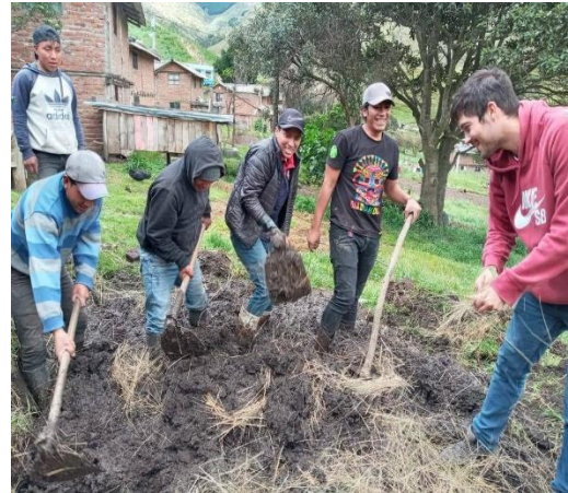
Figura 24. Mezclado de fango con paja.
