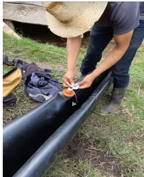
Figura 32. Hinchado del digestor para comprobar si existen fugas.
