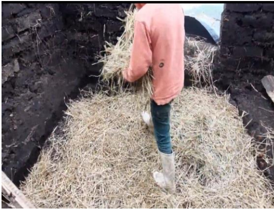
Figura 31. Preparación de la cama de paja sobre la que descansa el biodigestor.
