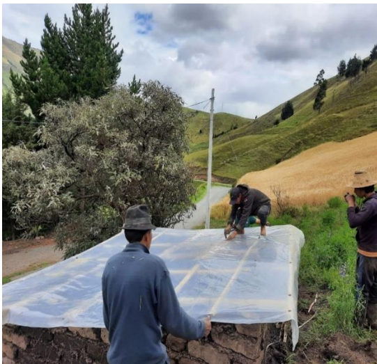
Figura 29. Colocación del plástico de invernadero como tejado.
