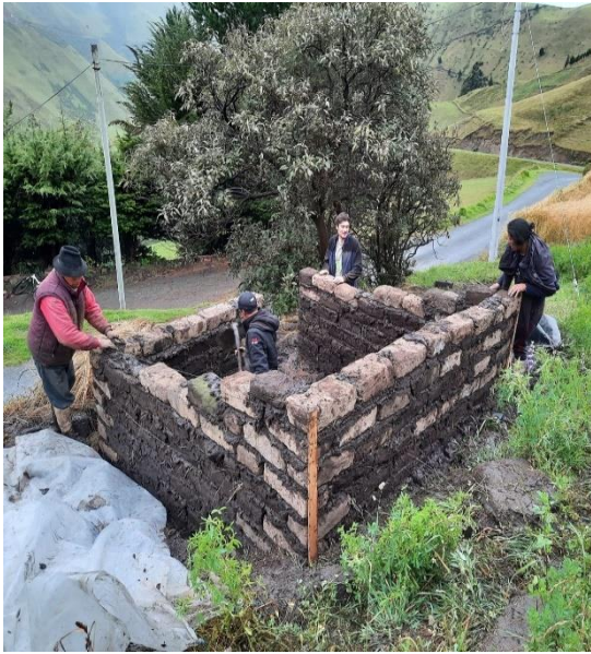
Figura 27. Construcción de las paredes.
