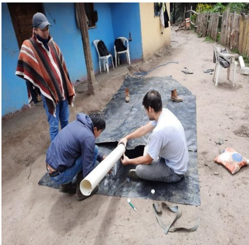
Figura 33. Sellado de tubos de entrada de materia prima o residuos agropecuarios y salida de digestato o biol con el digestor.
