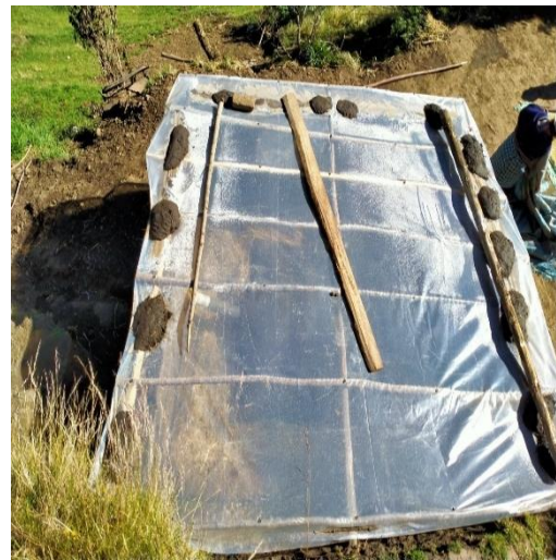
Figura 30. Caseta lista para la instalación del biodigestor.
