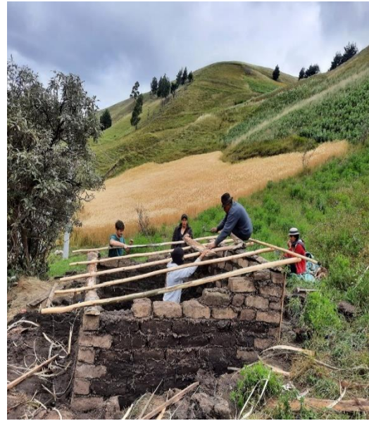
Figura 28. Colocación de vigas de madera del tejado.
