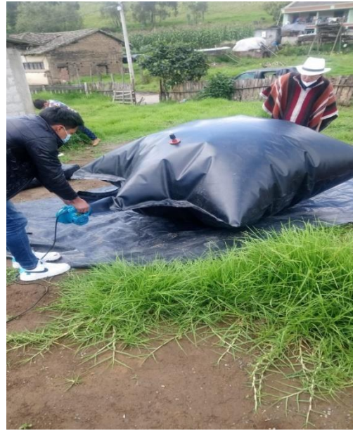
Figura 32. Hinchado del digestor para comprobar si existen fugas.
