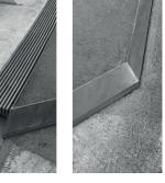
$\blacktriangle$   $\blacktriangledown$  Detalle de borde metálico para formación de andanas de autobús.
