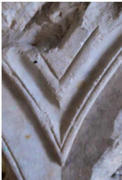
**Fig. 54.** Detalle de las líneas de estradós en la parte del reverso que pierden su continuidad.
