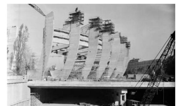
Figura 40. Plataformas para la puesta a punto del pretensado en cabeza de soporte.
