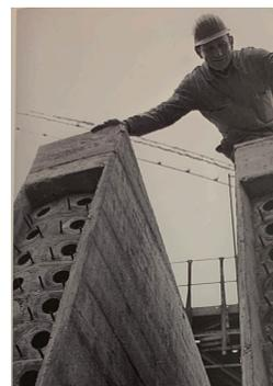
**Figura 41.** Huecos para cables de pretensado
