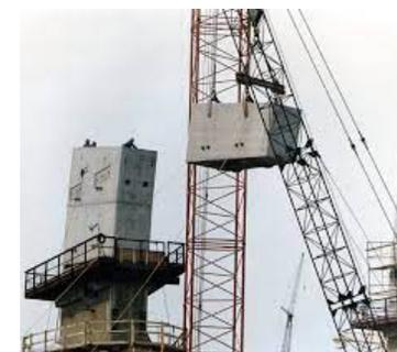
**Figura 43.** Levantamiento de los las piezas para su puesta en obra
