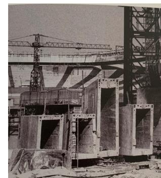
**Figura 42.** Módulos de hormigón armado fabricados in situ
