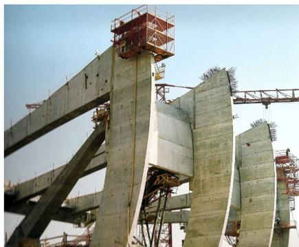
**Figura 47.** Pórticos con doble dirección de cables de pretensado
