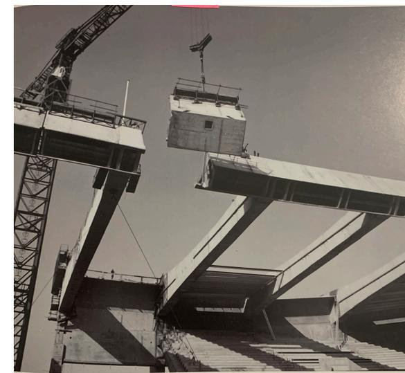
**Figura 50.** Instalación de la última pieza del anillo central
