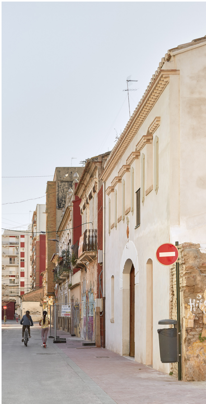
Figura 3.3.1: Entrada al edificio desde la Calle San Pedro Autora: Mariela Apollonio
