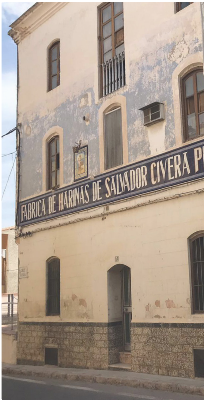
Figura 3.2.1: Acceso al edificio desde la Calle Acequia
