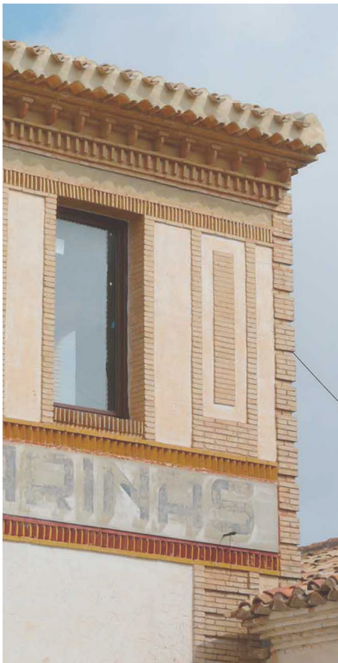
Figura 3.1.3: Ventana y aleros rehabilitados del exterior del edificio Autora: Elena Bosque Domínguez
