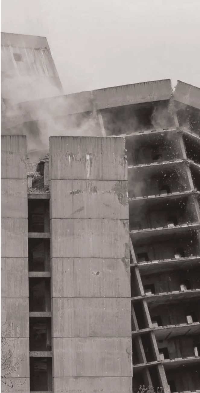
Figura 1.1: Edificio en proceso de derribo
