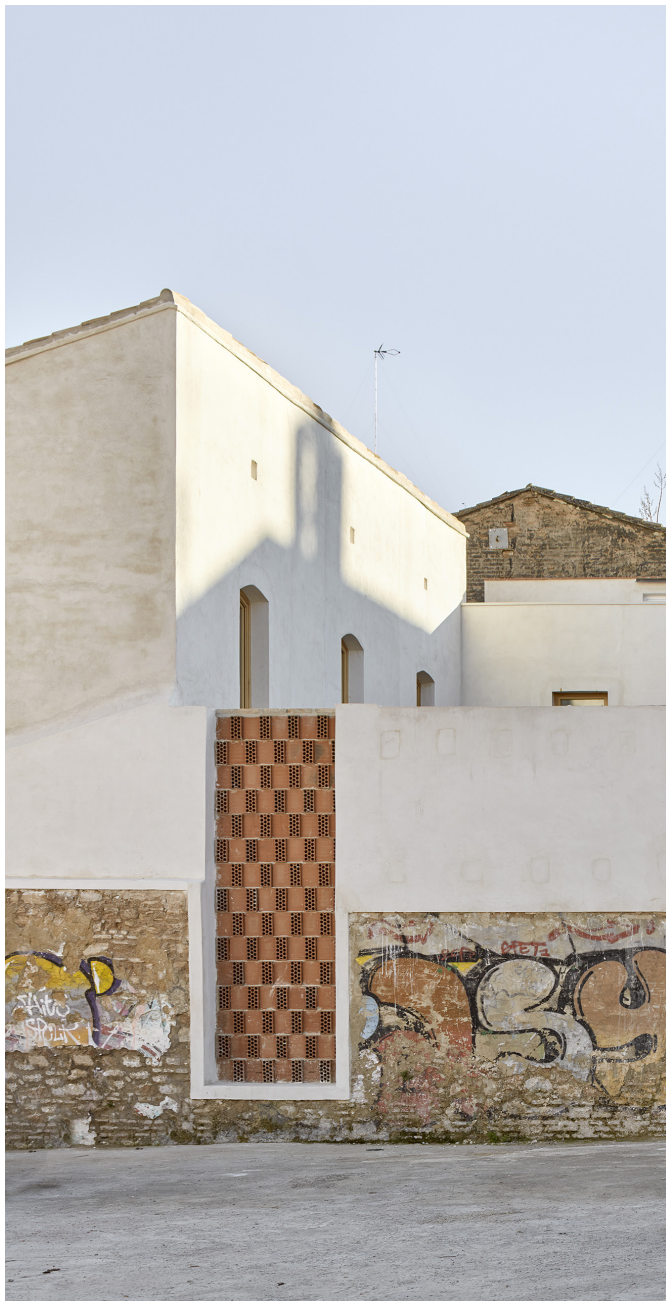
Figura 3.3.3: Exterior del edificio desde el lateral Autora: Mariela Apollonio
