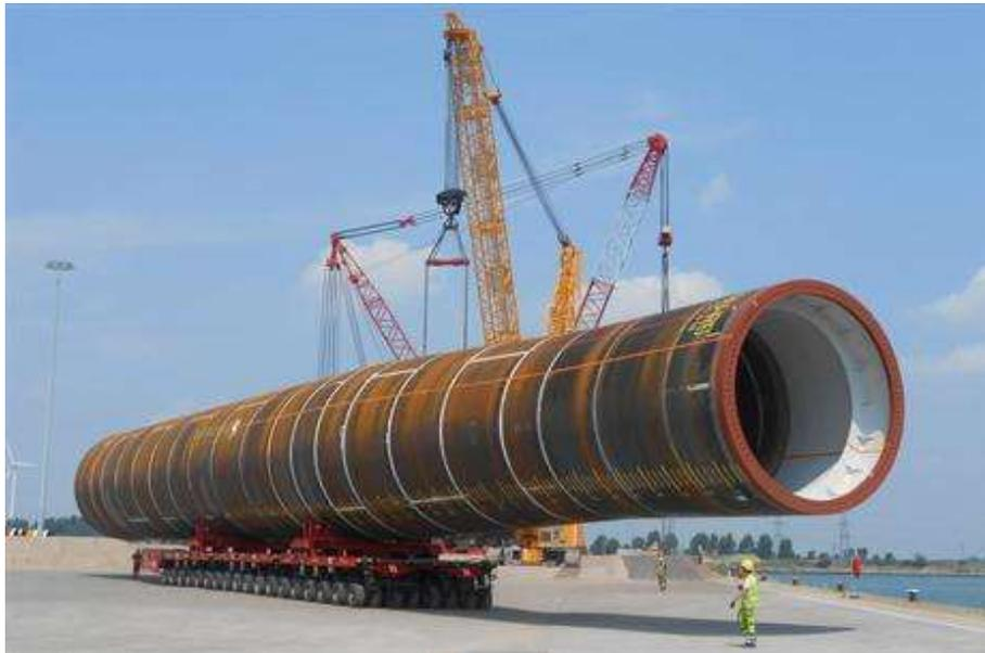
**Imagen 55. Transporte del monopilote para su carga en barco. Fuente: Sif Group.**
