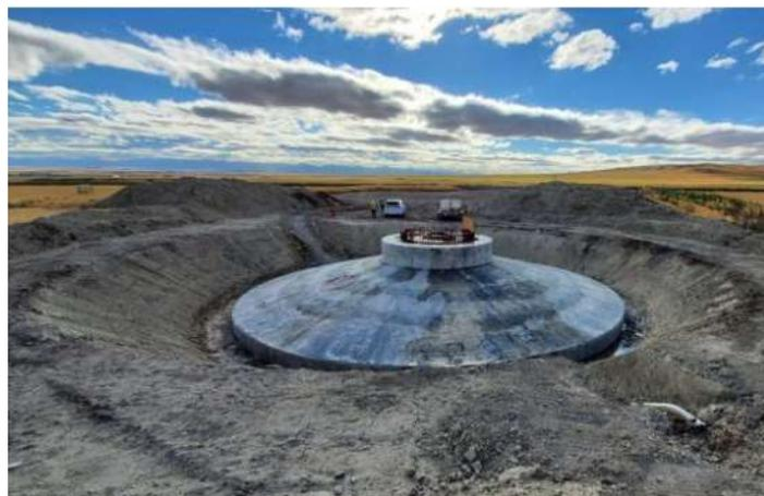
**Imagen 15. Cimentación aerogenerador onshore. Fuente: FPrimeC Solutions (2019).**
