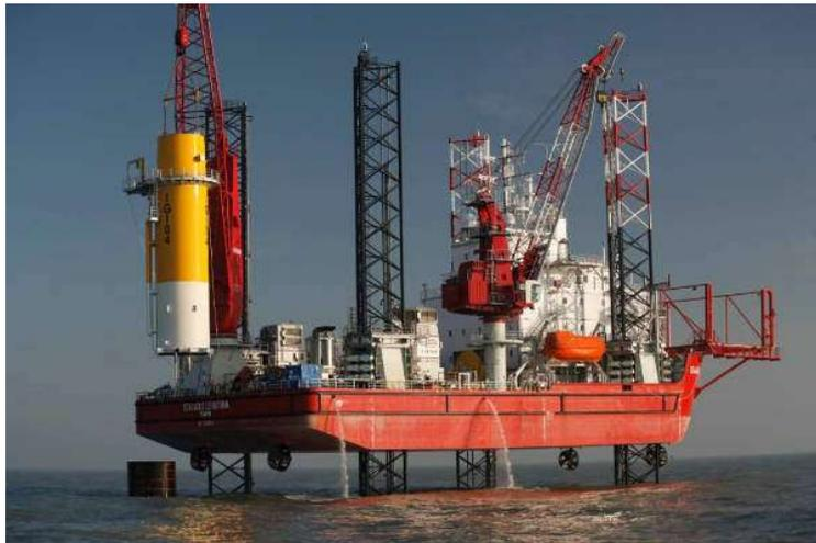
**Imagen 58. Instalación pieza transición. Fuente: Norther (2019).**
