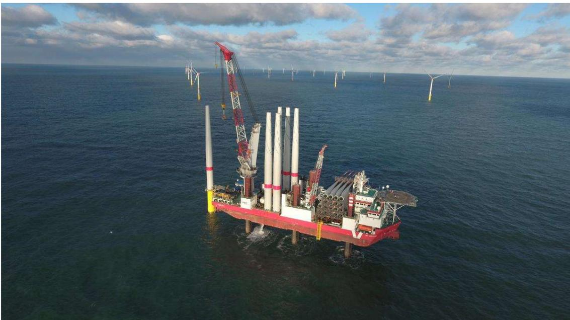
**Imagen 60. Instalación componentes aerogenerador. Fuente: MPI Offshore (2018).**
