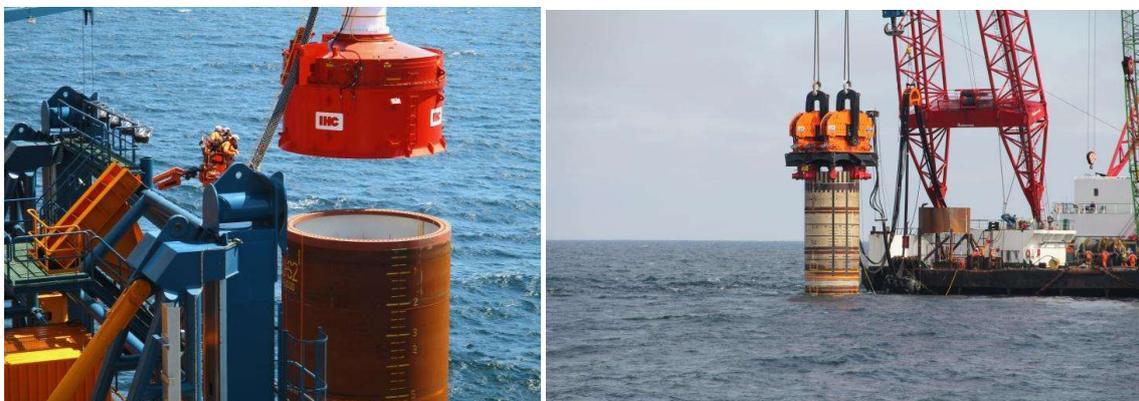
**Imagen 57. Izqda: hincado de pilotes mediante hammer. Dcha: vibrohincado. Fuente: Gemini (2015).**
