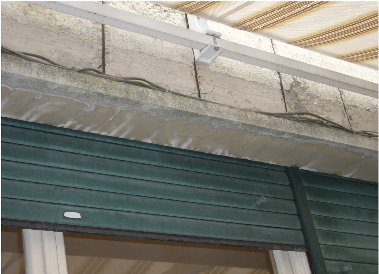
Dettaglio dei cordoli dei solai con in evidenza la relativa staffatura
