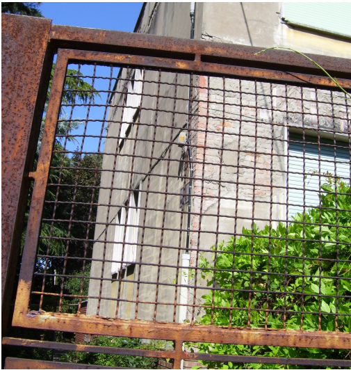
Le parti metalliche sono in avanzato stato di ossidazione.
