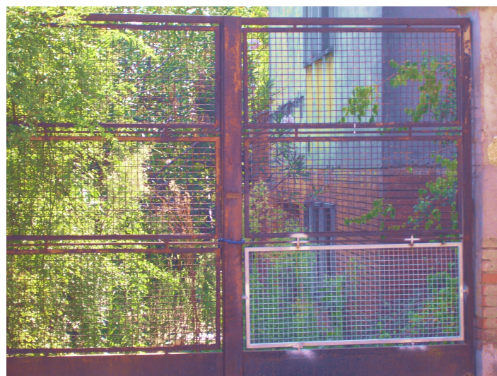
Las verjas metálicas están en un estado avanzado de oxidación.
