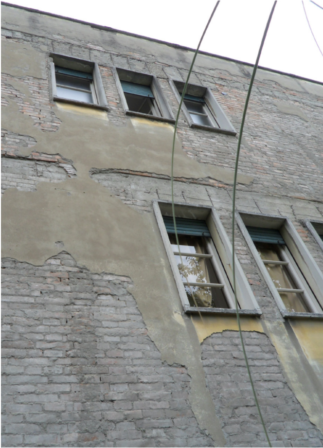
Facciata laterale / Dettaglio impermeabilizzazione del terrazzo
