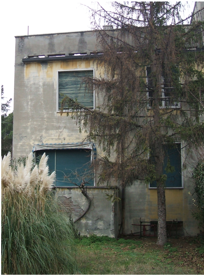
Le parti metalliche sono in avanzato stato di ossidazione.
