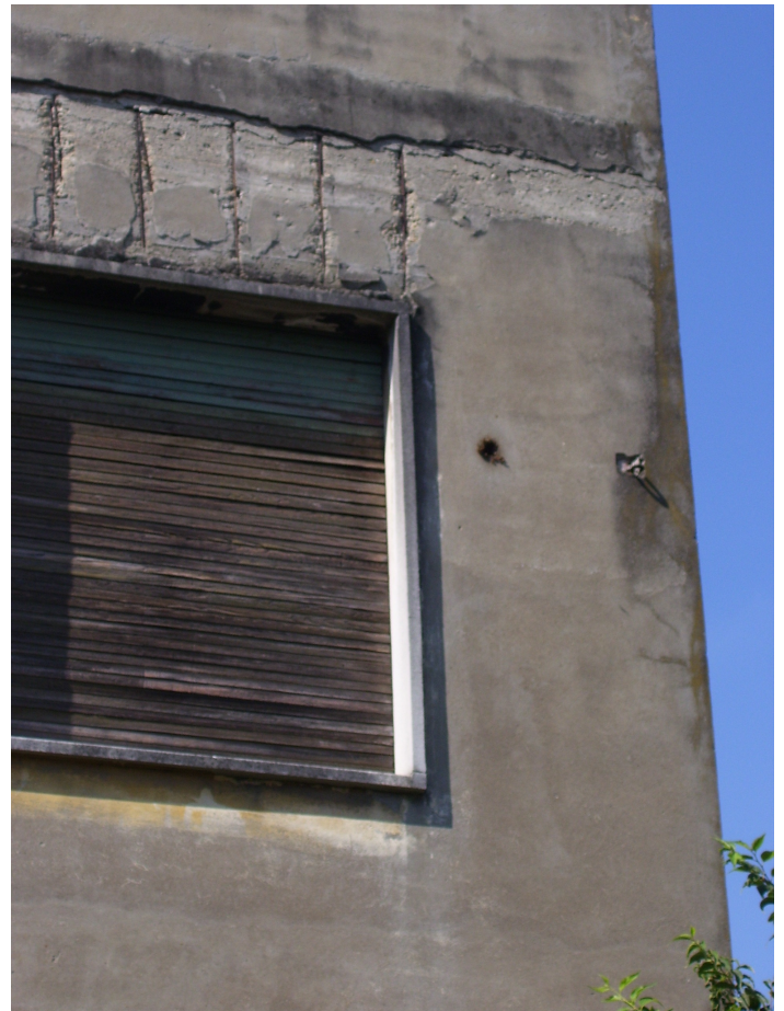
Las verjas metálicas están en un estado avanzado de oxidación.
