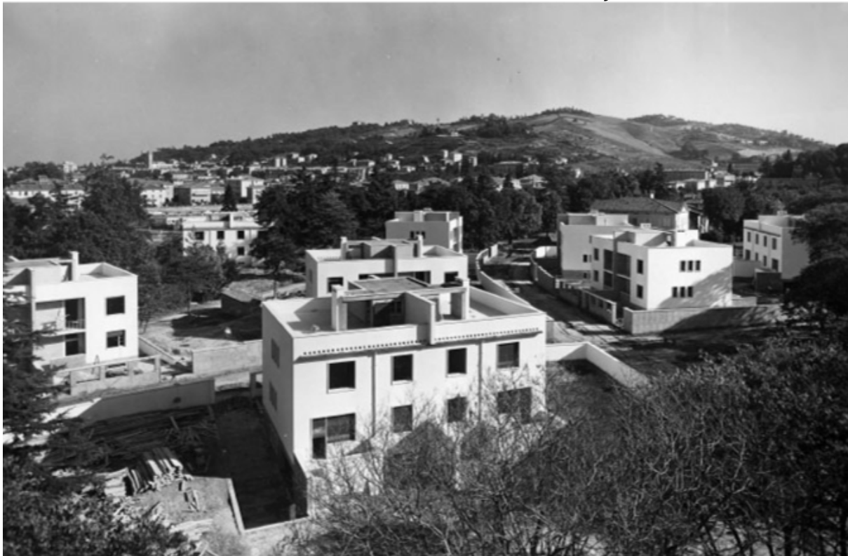
Foto storica del Villaggio della Rivoluzione Fascista durante la costruzione.
