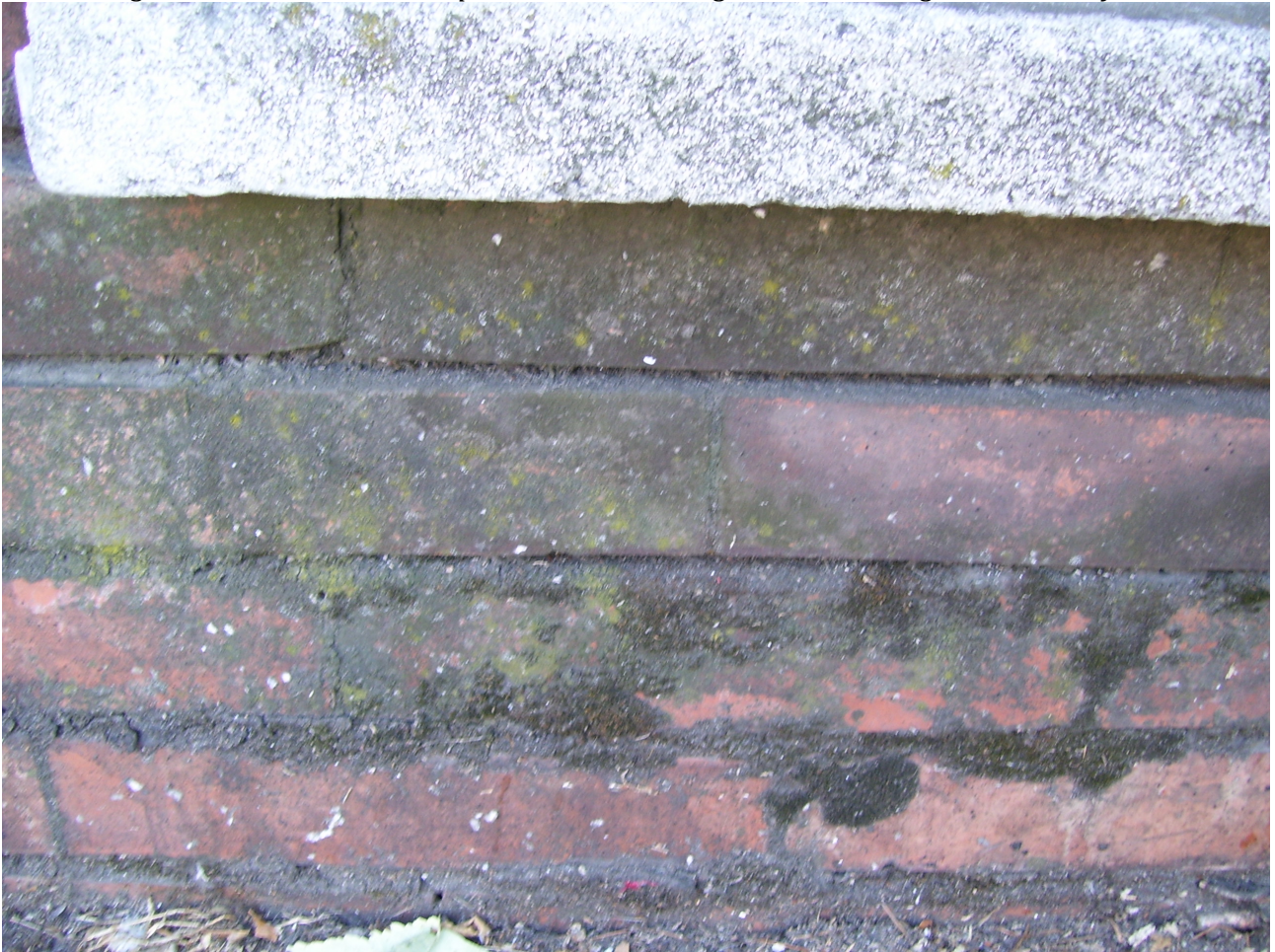
Degrado biologico sul basamento delle palazzine
