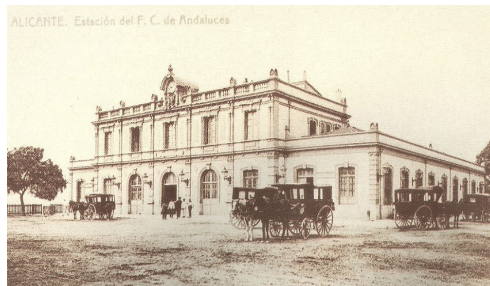
Estación de Benalúa. Foto de Bodewig, R. (2007, septiembre 15). Barrio de Benalúa: La Estación de Benalúa (III): Del abandono al futuro. http://www.barriodebenalua.es
