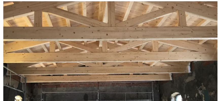
Cerchas restauradas de la estación de Martos. Foto del Ayuntamiento de Martos.
