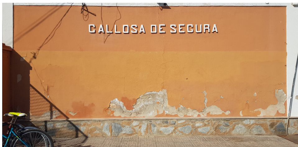
Fachada lateral de Callosa de Segura con distintos colores en fachada.
