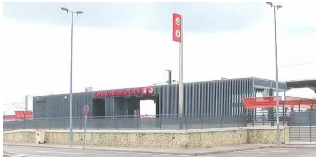
Nueva estación de Albaterra-San Isidro-Catral 2020. Foto de TV Vega Baja.
