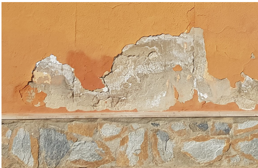
Detalle del muro. Foto autor
