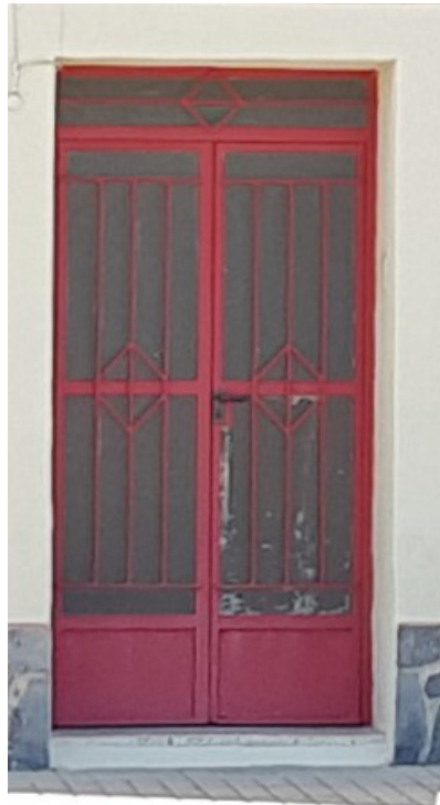
Puerta con carpintería metálica. Foto de autor.
