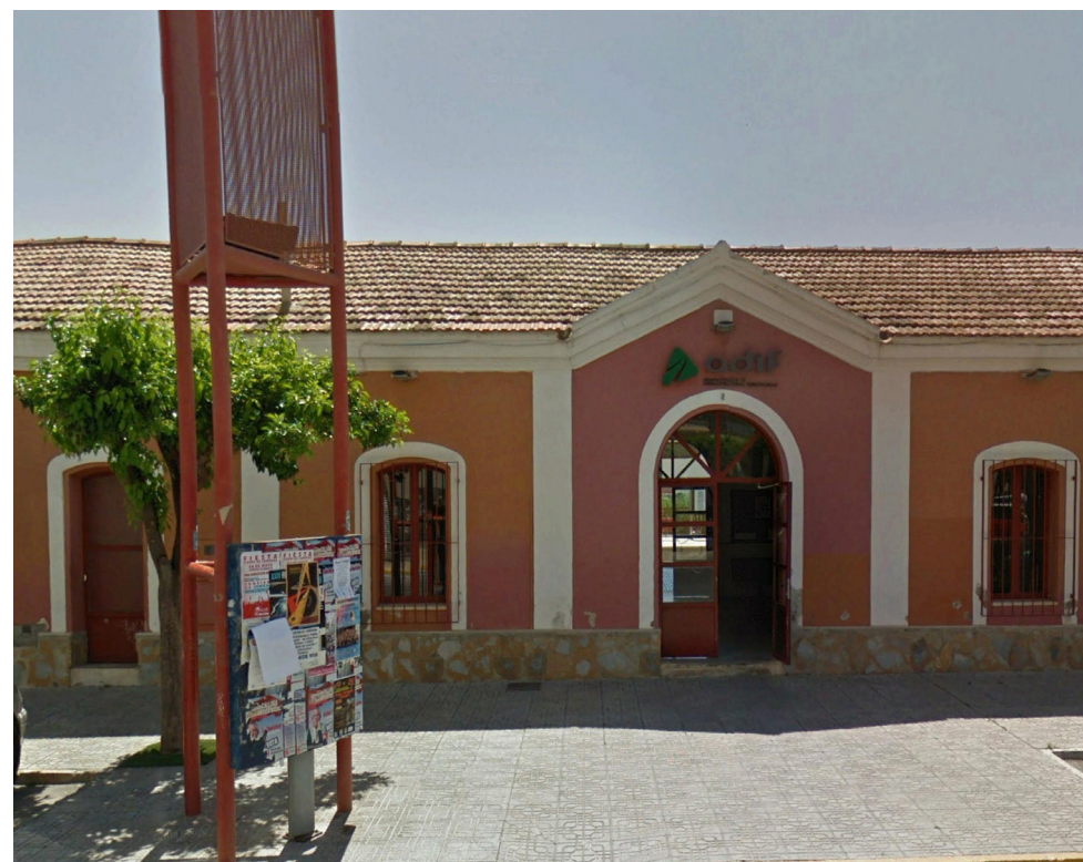
Fachada principal de Callosa de Segura con distintos colores en fachada.
