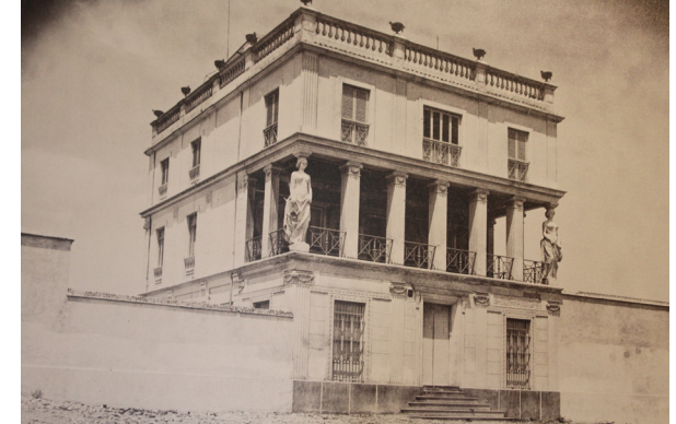
Figura 8 Antigua fachada principal
