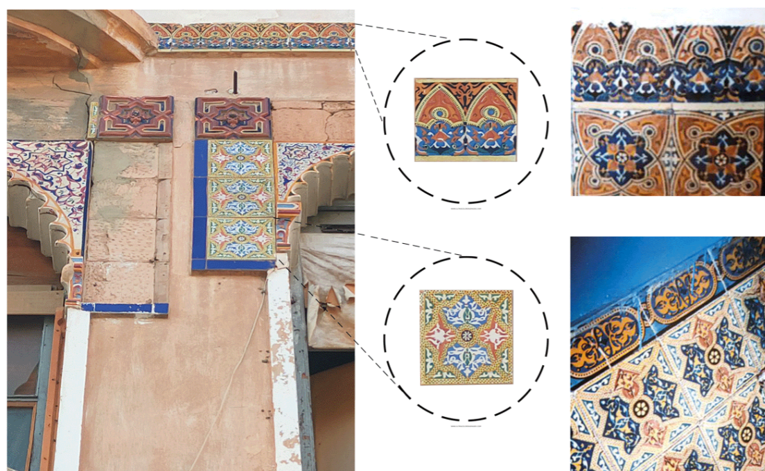
Fig.43. Identificación de procedencia y localización actual de la azulejería del edificio en calle Manuel Arnau 9. Ilustración de elaboración propia
