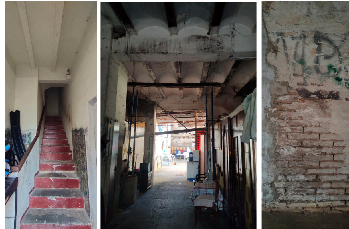
Fig.66. Interior edificio calle Manuel Arnau 9. Fotografías elaboración propia
