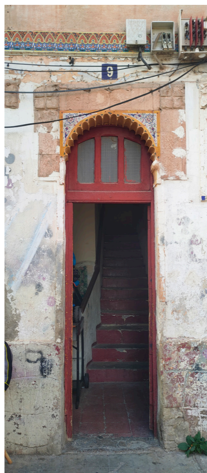
Fig.34. Fotografía entrada principal vivienda calle Manuel Arnau, 9. Fuente: elaboración propia, 2021
