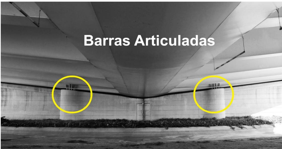
*Imagen 65. Apoyo Articulado del tablero en el estribo Norte*
