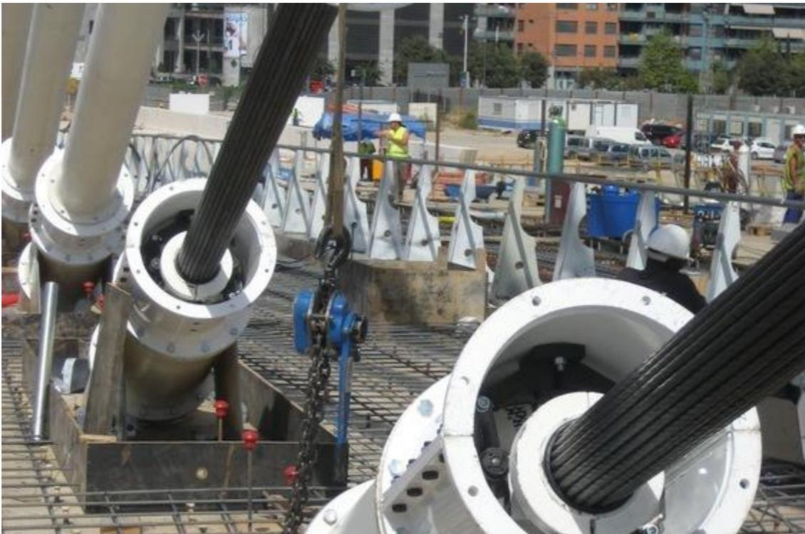
Imagen 88. **Amortiguador en tirantes del tablero**
