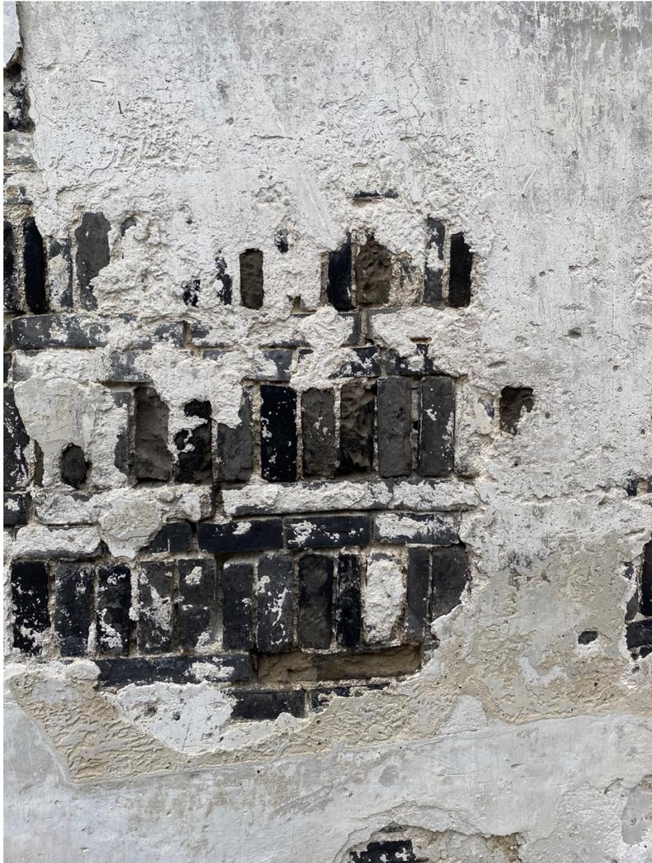
***[Fig.88] Pintura de cal en el muro exterior, Nanxun***
