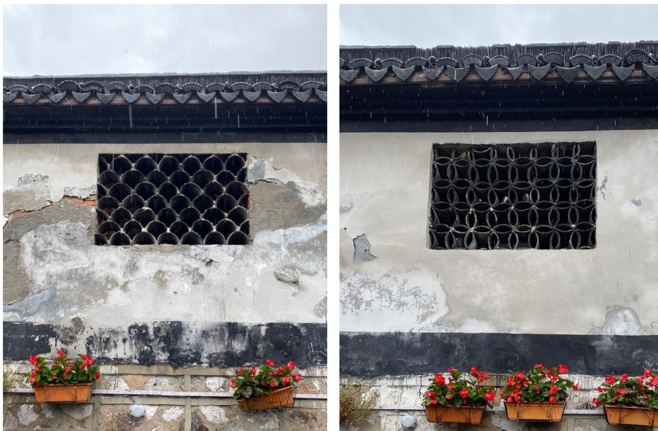
**[Fig.90] Ventanas goteras de tejas, Nanxun**
