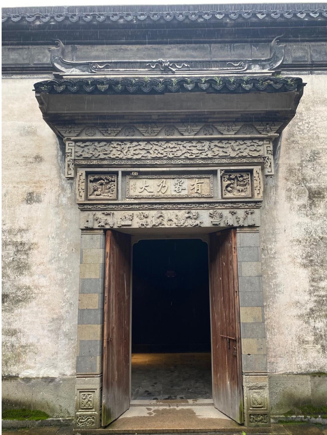
***[Fig.89] Puerta decorada con talla de ladrillos y tejas, Nanxun***
