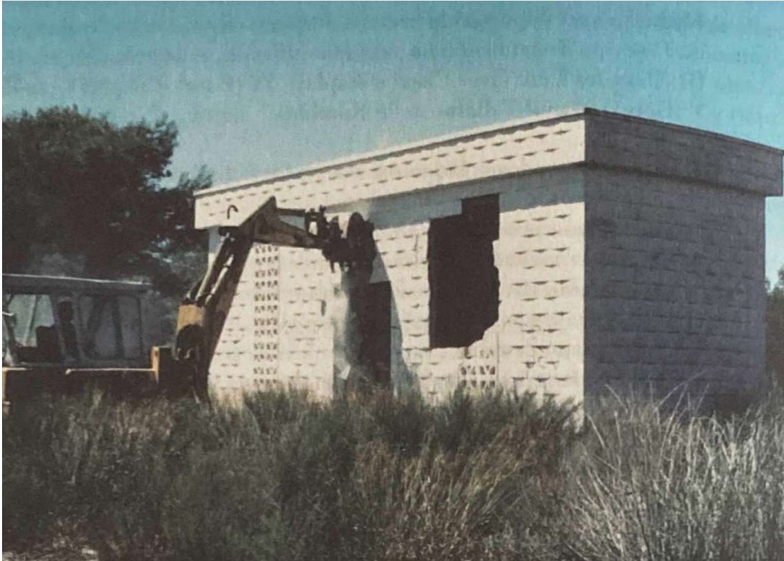
F19. Imagen de la demolición de una casera de abastecimiento eléctrico. Fuente: DEVESA DEL SALER Soluciones de futuro 14
