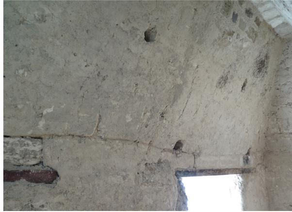
Figura 6.58 Perforaciones en la bóveda para los morillos Cuarto 2. (Fotografía: L. Gilabert Sansalvador 2017).
