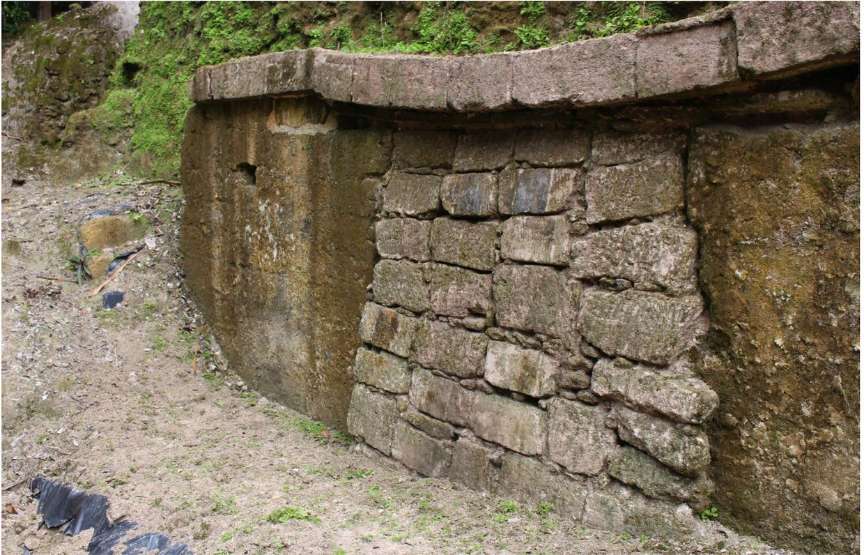
*Figura 7.7 Manchas de suciedad debidas a la escorrentía en la fachada del Cuarto 1 de la subestructura. (Fotografía: R. Martínez Vanaclocha 2015).*
