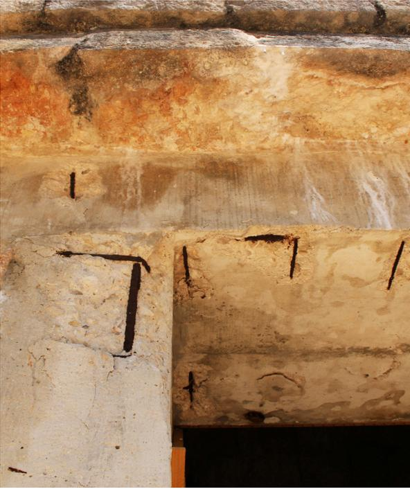
Figura 7.15 Detalle de la restauración mediante hormigón armado de uno de los vanos del palacio oeste del Cuadrángulo de las Monjas (Yucatán, México). (Fotografía: R. Martínez Vanaclocha 2015).
