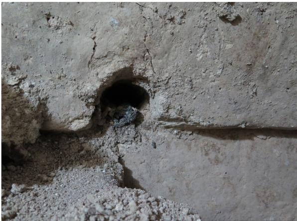
Figura 6.36 Perforación de uno de los morillos con restos de madera en estado de pudrición. (Fotografía: L. Gilabert San-salvador 2017).
