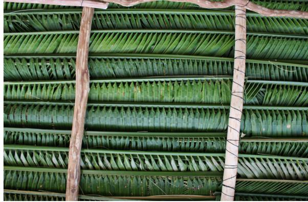
Figura 8.10 Cubierta de palma recién terminada. (Fotografía: R. Martínez Vanaclocha 2015).
