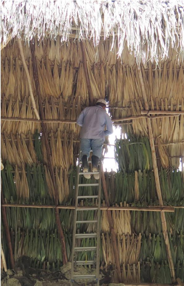
Figura 8.9 Reparación de la cubierta del ala oeste del edificio 6J2 Sub de La Blanca. (Fotografía: L. Gilabert Sansalvador 2017).
