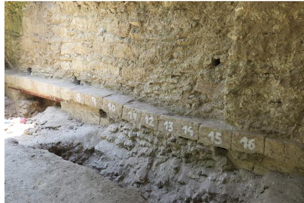
Figura 7.2 Numeración de las piezas de cornisa de la puerta central del Cuarto 2 de la subestructura antes de su restauración donde se puede apreciar el descenso hacia la parte central. (Fotografía: L. Gilabert Sansalvador 2016).
