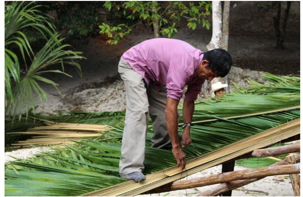
Figura 7.21 Elaboración de una de las cubiertas en el edificio 6J2 Sub de La Blanca. (Fotografía: R. Martínez Vanaclocha 2015).
