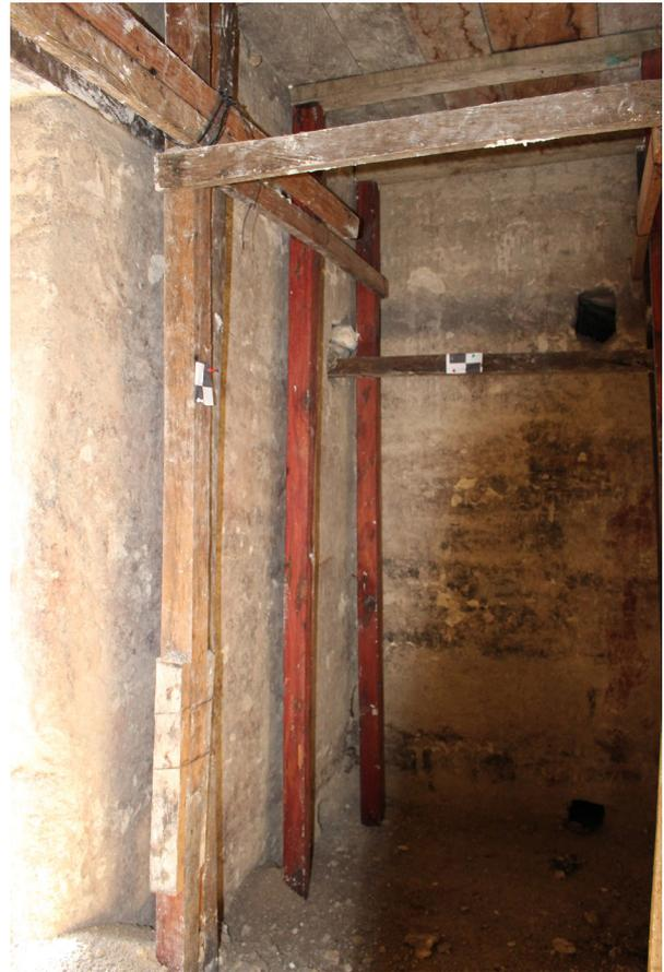
Figura 7.18 Apeo del interior del Cuarto 1 durante la excavación. (Fotografía: R. Martínez Vanaclocha 2015).
