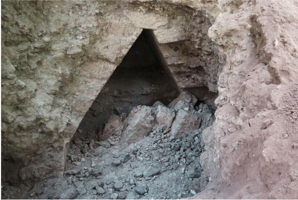
Figura 7.3 Desprendimiento de las dovelas Cuarto 3 de la subestructura. (Fotografía: L. Gilabert Sansalvador 2016).
