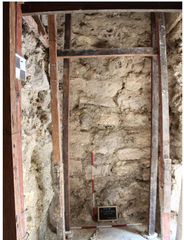
Figura 6.12 Detalle del entibado en el interior del Cuarto 1 (Fotografía: R. Martínez Vanaclocha 2015).
