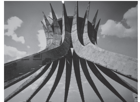
Imagen 55. Proceso constructivo de la Catedral
