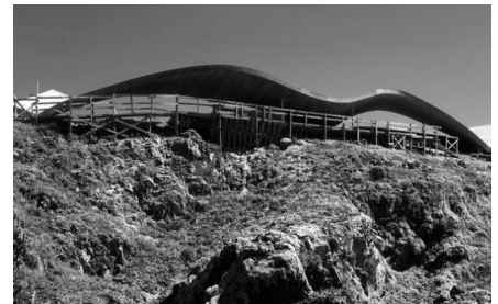
Imagen 8. Exterior Casa en Los Vilos en construcción.
