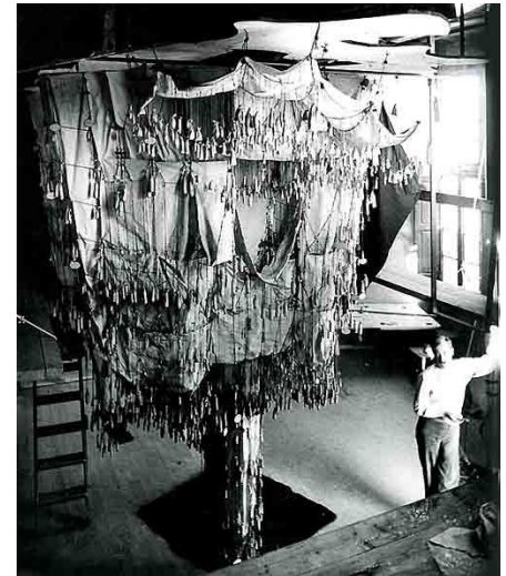
Imagen 3. Fotografía de maqueta funicular de Gaudí para Güell.
