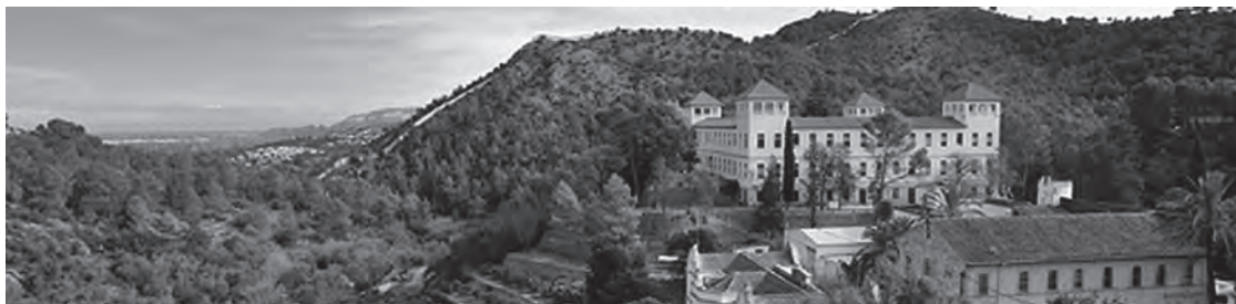
Figura 02. Sanatorio San Francisco de Borja de Fontilles. Vista parcial del valle y de las edificaciones que lo componen.
