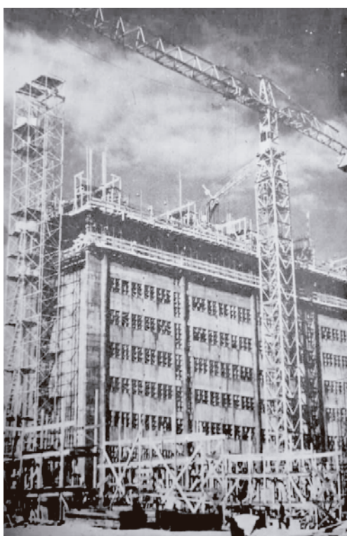
Figura 91. Ejecución del edificio con el sistema de moldes deslizantes. Fuente: Segre, Roberto. La vivienda en Cuba en el siglo XX: República y Revolución . 1980. Editorial Concepto. 11 de agosto de 2021.
