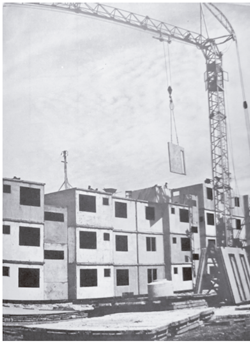
Figura 107. Proceso de montaje. Fuente: Segre, Roberto. La vivienda en Cuba en el siglo XX: República y Revolución . 1980. Editorial Concepto. 11 de agosto de 2021.
