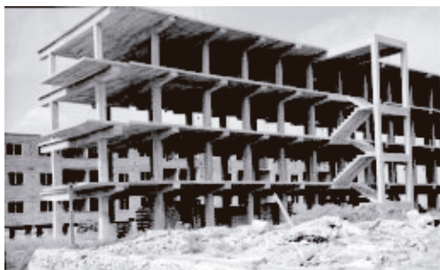
Figura 36. Proceso de construcción de los bloques donde se aprecia el sistema estructural empleado. Fuente: Peñate Díaz, Florencia. La vivienda del pobre en La Habana de la República . 15 de junio de 2021. https://www.redalyc.org/articulo.oa?id=376839862004
