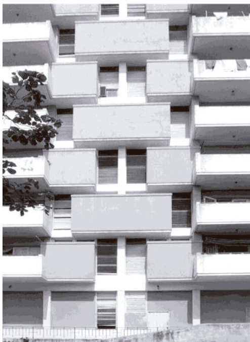
Figura 55. Detalle de armarios en fachada. Fuente: Gómez Díaz, Francisco. La colonización de La Habana al este de su bahía: la Unidad Vecinal número 1 "Camilo Cienfuegos" . 2018. Ciudad y formas urbanas Perspectivas transversales Volumen 9. Formas urbanas y vivienda en las ciudades latinoamericanas. 4 de agosto de 2021. https://eventos.unizar.es/_files/_event/_11844/_editorFiles/file/Publicaciones/Volumen%209%20Actas%20Congreso%20ISUF-H.pdf
