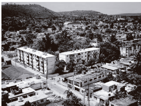
Figura 110. Edificios Gran Panel IV en el centro de Holguín en 2010. Fuente: González Couret, Dania. La industrialización de la vivienda en Cuba. Década del 70 . 2021. Arquitectura y Urbanismo n. 1. 11 de agosto de 2021. https://rau.cujae.edu.cu/index.php/revistaau/article/view/604
