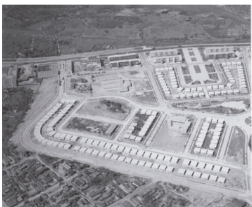
Figura 33. Vista de la ordenación urbana del barrio, con la Vía Blanca discurriendo paralela a la línea doble de bloques en altura, mientras que el resto de viviendas se organizan alrededor de los espacios públicos. Fuente: López Rangel, Rafael. Reflexiones sobre la Arquitectura y el Urbanismo Latinoamericanos . 10 de junio de 2021. http://www.rafaellopezrangel.com/galeria%20habana.htm
