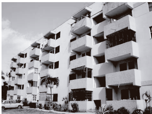
Figura 127. Edificio típico E 14. Fuente: González Couret, Dania. La industrialización de la vivienda en Cuba. Década del 70. 2021. Arquitectura y Urbanismo n. 1. 11 de agosto de 2021. https://rau.cujae.edu.cu/index.php/revistaau/article/view/604
