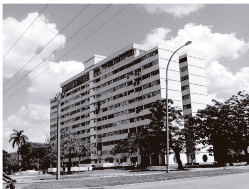
Figura 120. Proyecto típico SP72. Fuente: González Couret, Dania. La industrialización de la vivienda en Cuba. Década del 70. 2015. Arquitectura y Urbanismo n. 1. 11 de agosto de 2021. https://rau.cujae.edu.cu/index.php/revistaau/
