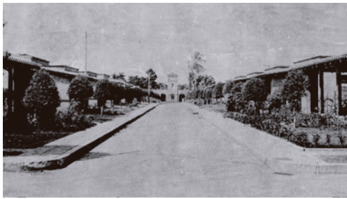
Figura 23. Vista parcial de una zona de la barriada donde se aprecia la utilización del modelo de Ciudad Jardín. Fuente: Milian Bernal, Emba y Delgado Cabrera, Reinaldo. EL REPARTO LUTGARDITA -SEGUNDO BARRIO OBRERO DE CUBA EN LA REPÚBLICA (1929-1933). UN MODELO URBANÍSTICO DE LA ETAPA REPUBLICANA . 25 de mayo de 2021. https://www.facebook.com/bernamilian/posts/898376117208553/
