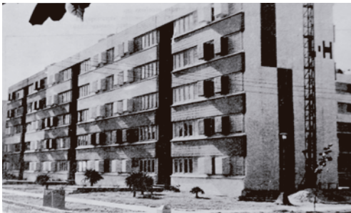
Figura 122. Solución formal de los edificios. Fuente: Segre, Roberto. La vivienda en Cuba en el siglo XX: República y Revolución . 1980. Editorial Concepto. 11 de agosto de 2021.
