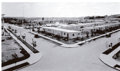
Figura 37. Vista de las viviendas unifamiliares distribuidas alrededor de un espacio público. Fuente: Los tres grandes barrios obreros de La Habana antes de 1959 . 15 de junio de 2021. https://www.todocuba.org/los-tres-grandes-barrrios-obreros-la-habana-1959/
