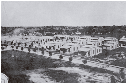
Figura 29. Vista de una serie de viviendas correspondientes a la segunda variante de dos dormitorios que evidencia la solución de cubierta fragmentada en las tres piezas que componen la unidad. Fuente: Milian Bernal, Emba y Delgado Cabrera, Reinaldo. EL REPARTO LUTGARDITA -SEGUNDO BARRIO OBRERO DE CUBA EN LA REPÚBLICA (1929-1933). UN MODELO URBANÍSTICO DE LA ETAPA REPUBLICANA . 25 de mayo de 2021. https://www.facebook.com/bernamilian/posts/898376117208553
