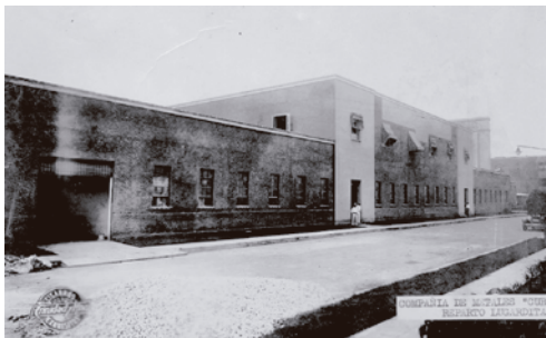
Figura 24. Edificación de una de las industrias creadas en el reparto. Fuente: Milian Bernal, Emba y Delgado Cabrera, Reinaldo. EL REPARTO LUTGARDITA -SEGUNDO BARRIO OBRERO DE CUBA EN LA REPÚBLICA (1929-1933). UN MODELO URBANÍSTICO DE LA ETAPA REPUBLICANA . 25 de mayo de 2021. https://www.facebook.com/bernamilian/posts/898376117208553/
