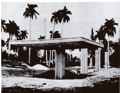
Figura 84. Sistema estructural compuesto por una losa nervada y un único pilar. Fuente: Segre, Roberto. La vivienda en Cuba en el siglo XX: República y Revolución . 1980. Editorial Concepto. 11 de agosto de 2021.
