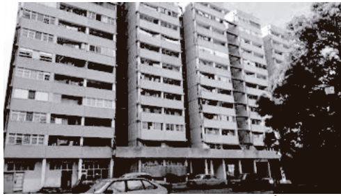
Figura 117. Fachada de proyecto típico IMS. Fuente: González Couret, Dania. La industrialización de la vivienda en Cuba. Década del 70. 2021. Arquitectura y Urbanismo n. 1. 11 de agosto de 2021. https://rau.cujae.edu.cu/index.php/revistaau/article/view/604
