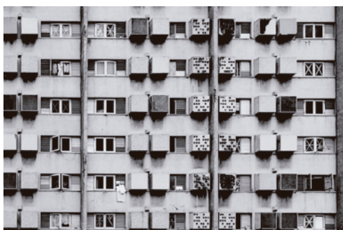
Figura 96. Armarios extruidos en fachada. Fuente: Edificio Girón-La Habana . 2017. 11 de agosto de 2021. http://travelogues.me/albums/edificio-giron-la-habana/
