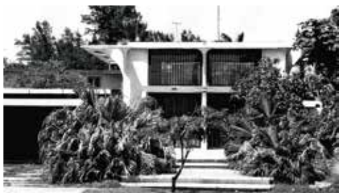
Figura 64. Casa de Higinio Miguel. Fuente: Bancells, Lina. En Varadero y La Habana destruyen el patrimonio arquitectónico republicano . 2021. Diario de Cuba. 5 de agosto de 2021. https://diariodecuba.com/cultura/1620823776_31017.html
