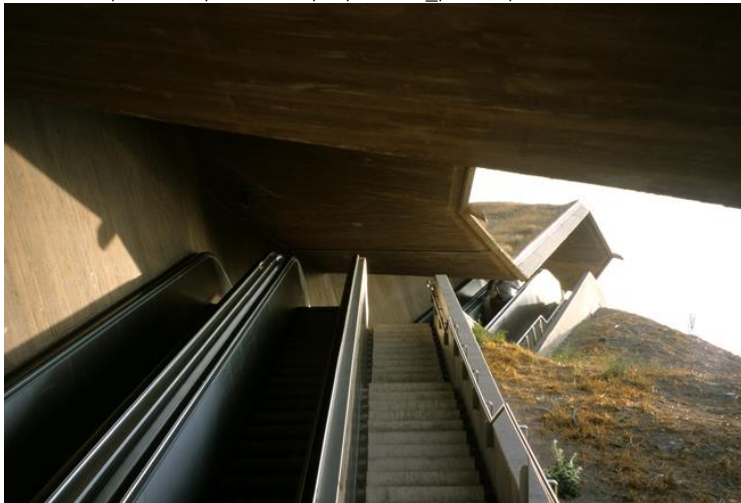
Figura 72. Vista desde el tramo 5 de la escalera mecánica. Fuente: http://www.jamlet.net/projects/01_publicspace/PS15/index.html
