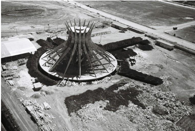
Figura 67. Imagen de la catedral durante la excavación, con el terreno que formará el descenso, abierto. Fuente: https://catalogo.artium.eus/dossieres/exposiciones/premios-pritzker-viaje-por-la-arquitectura-contemporanea/obra-seleccionada-5
