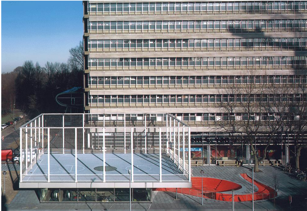
Figura 64. Enterrado bajo el suelo se ubica la cafetería del campus de la Universidad de Utrecht, diseñada por NL Architects 2000|2003. En la superficie de la cubierta se programa una pista de baloncesto.
