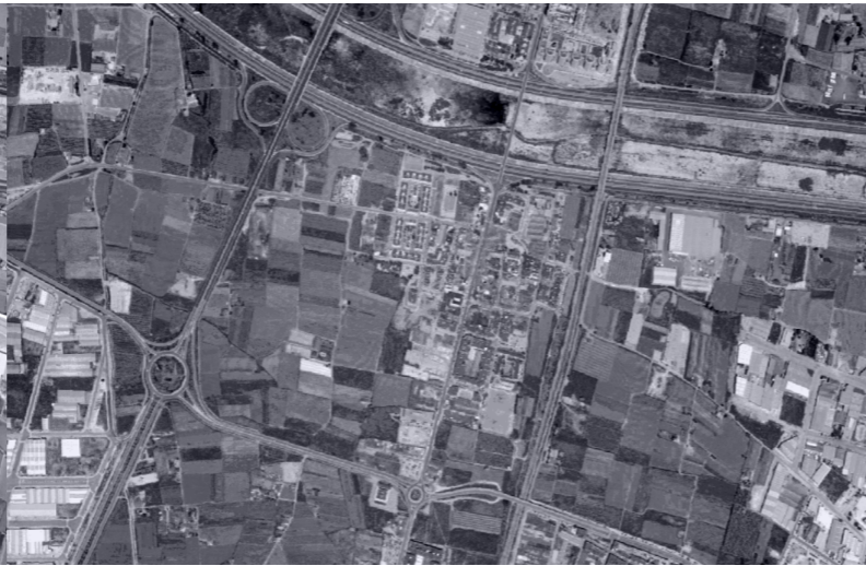
IMAGEN 8 Imagen aérea tomada en 2004. Fuente: INSTITUT CARTOGRÀFIC VALENCIÀ Editado por EL AUTOR
