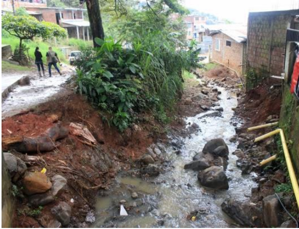
Ilustración 110 Quebrada en Siloé
