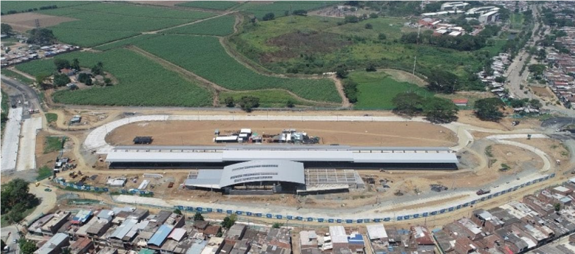
Ilustración 79 Terminal de Cabecera de Aguablanca
