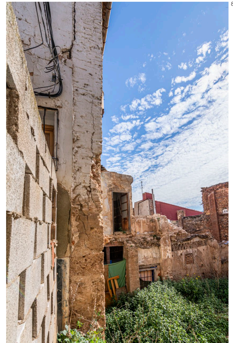
Imagen (8.3) Tabique interior. Imagen (8.4) Tabique interior. Imagen (8.5) Añadido de mampostería para realizar la cubierta a dos aguas. Imagen (8.6) Refuerzo de esquina con el patio inferior de fondo.
