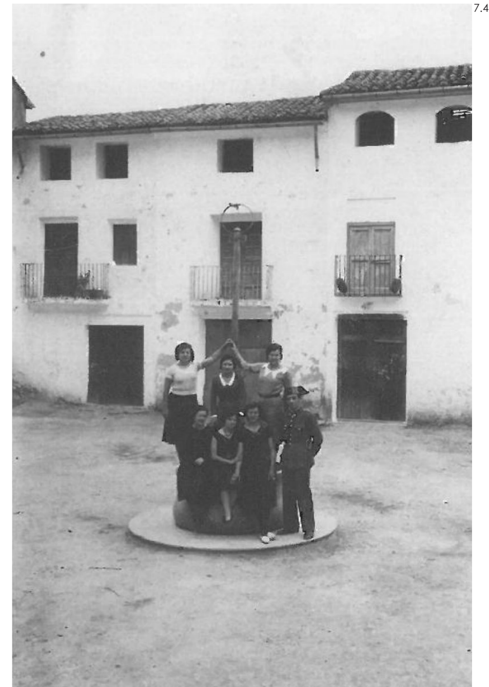
Imagen (7.4) Fuente en la plaza de la Constitución, en segundo plano, la vivienda a la izquierda corresponde al emplazamiento de la nueva construcción. Año 1955. Imagen cedida por el Taller A.
