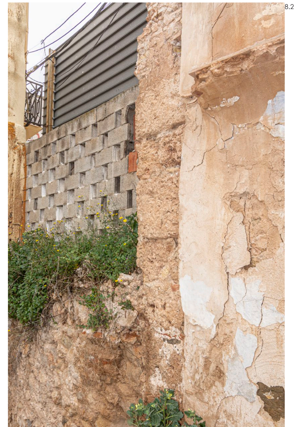
Imagen (8.1) "Sección constructiva" muro de tapia calicostrada. Imagen (8.2) Refuerzo en esquina, las primeras cajas de tapia están realizadas de piedra, las cajas superiores son reforzadas con ladrillo.
