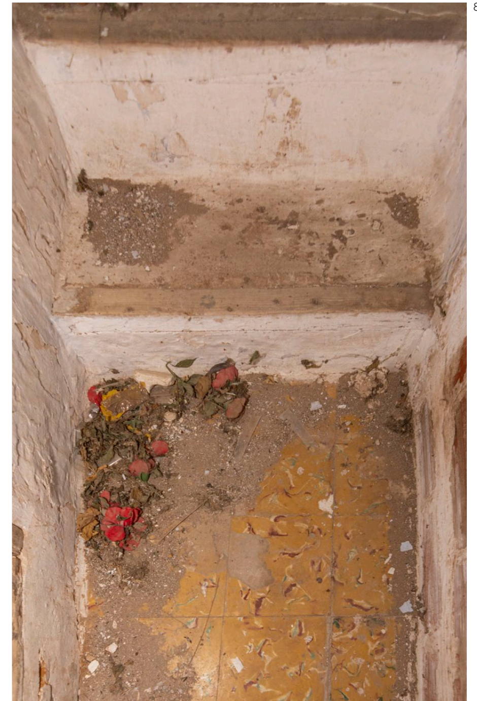
Imagen (8.28) Pavimento de mayor antigüedad de baldosa cerámica. Imagen (8.29) Pavimento más reciente dispuesto en la transformación de la vivienda.
