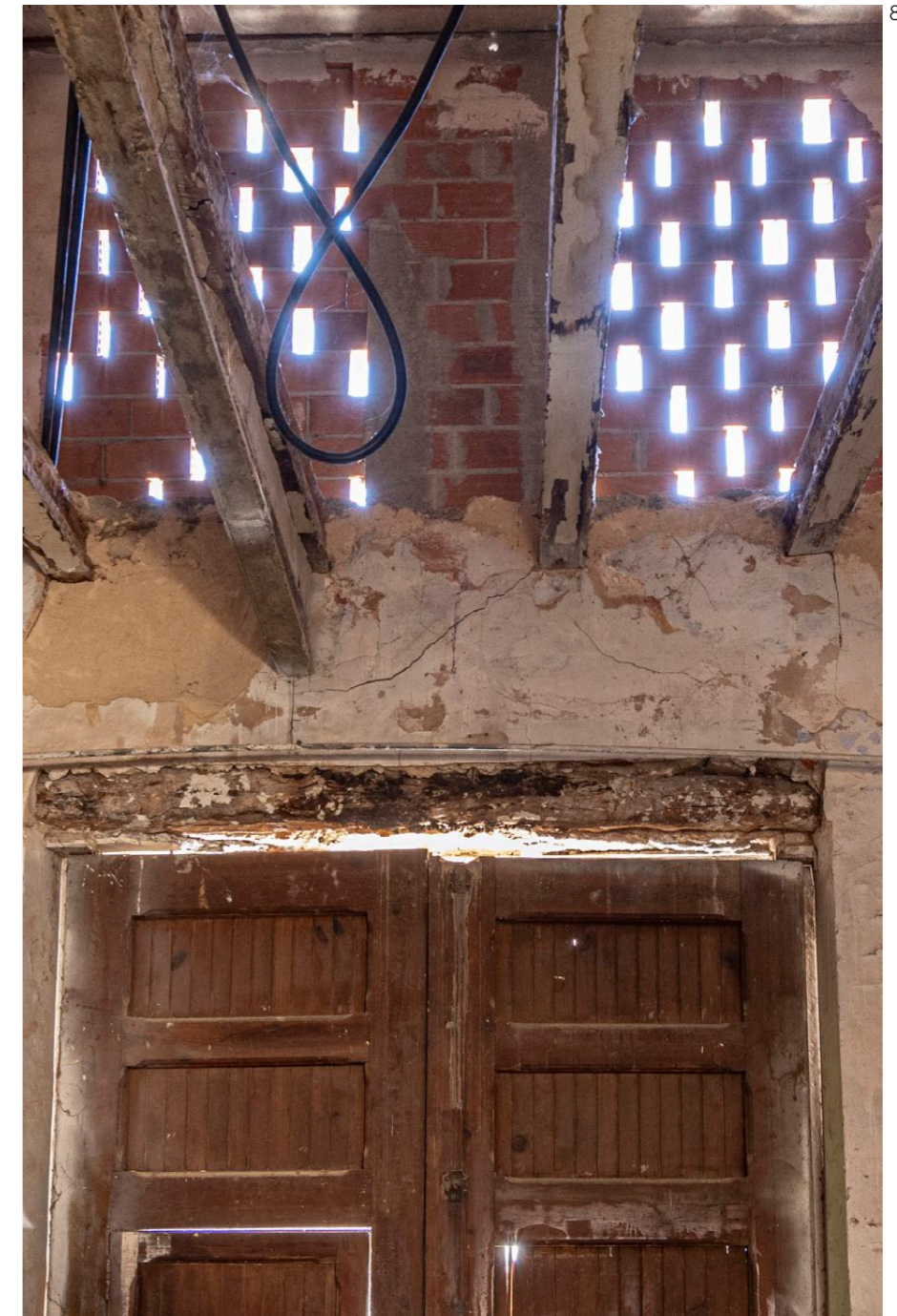
Imagen (8.10) Hueco cerrado realizado mediante u arco de ladrillo, con un hueco abierto a la izquierda. Imagen (8.11) Desprendimiento de la costra superficial en la esquina. Imagen (8.12) Viguetas restantes de la retirada del forjado y el cerramiento del hueco superior.
