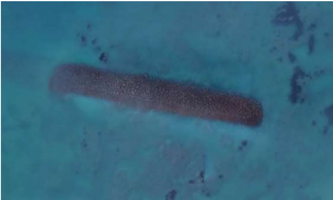
Figura 24. Estado actual del dique exento. Fuente: Google Maps
