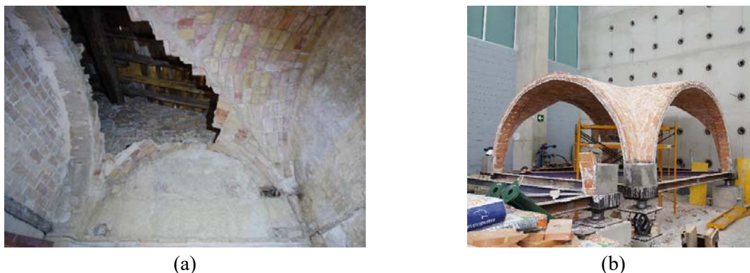
Figura 1. (a)- Colapso en bóveda tabicada de crucería en la Iglesia Parroquial San Lorenzo de Castell de Cabres (Castellón, España). (b)- Imagen de la bóveda una vez construida en los laboratorios de ICITECH, UPV.
