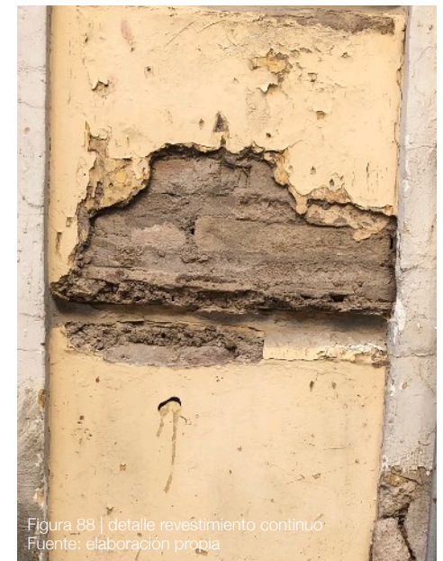
Figura 86 | detalle revestimiento continuo Fuente: elaboración propia
