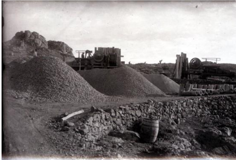
Figura 70: Construcción de infraestructuras de caminos. (Fuente: Lorenzo, 2019)
