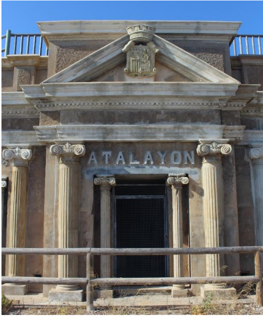
Figura 26: Estado actual del frontón con el escudo de la Segunda República. (Imagen propia)
