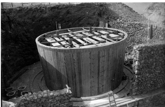
Figura 57: Una vez realizado el levantamiento de la mampostería se realizaba el encofrado del hueco para el cargador giratorio. (Fuente: Lorenzo, 2019)
