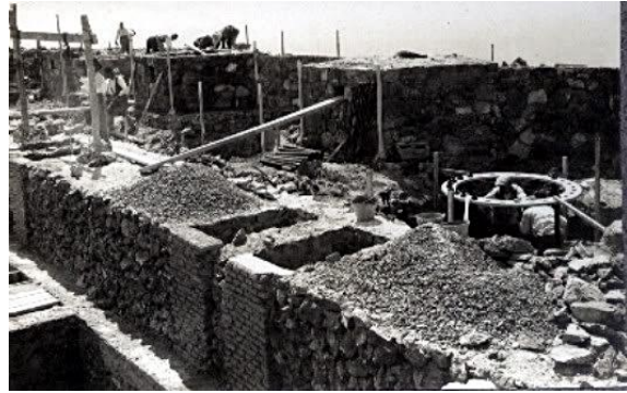
Figura 27: En esta imagen se puede entender con claridad la construcción de la explanada de tiro. En la parte de arriba de la foto se observan las barbetas realizadas con esa geometría tan característica. Además, a la derecha se puede ver como dos obreros están trabajando en el anclaje donde después irá situado uno de los Vickers destinados a esta batería. Por último, en el centro y esquina inferior izquierda de la fotografía, se aprecia los conductos que comunicaban con los locales semienterrados, así como el desfase de 2 metros entre el techo de estos y el suelo de la explanada de tiro. (Fuente: Hernández, 2017)
