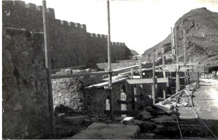
Figura 62: Construcción del edificio de taller y almacén. De igual manera, se puede observar el sistema de raíles para el transporte de material. (Fuente: Lorenzo, 2019)
