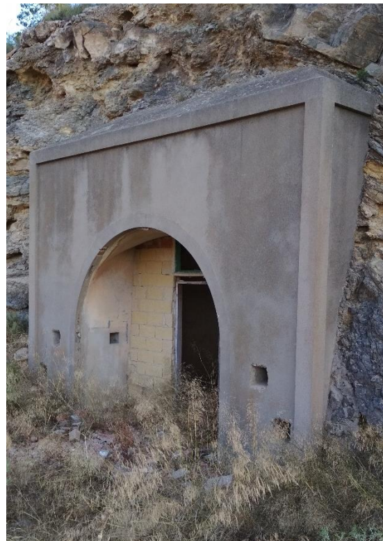
Figura 21: Entrada del pabellón de depósitos excavado en la roca. (Imagen propia)
