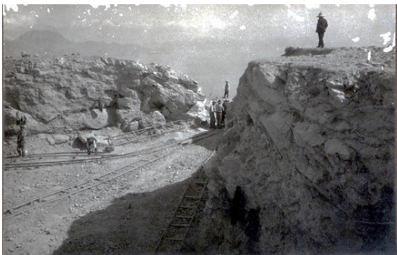
Figura 55: Labores de excavación y movimiento de tierras. (Fuente: Lorenzo, 2019)
