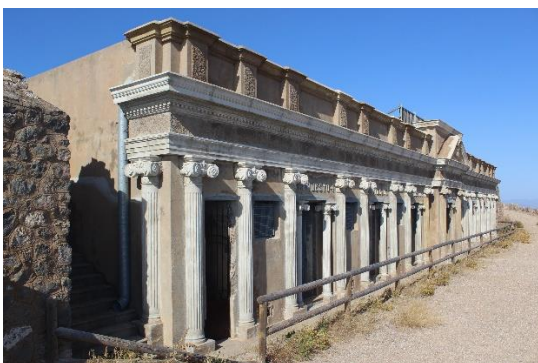
Figura 24: Edificio de repuestos después de la intervención. (Imagen propia)
