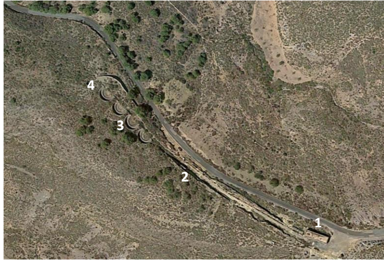
Figura 16: Foto aérea de la batería de Loma Larga. Se puede observar las cuatro barbetas donde en su día fueron montadas las piezas de artillería antiaérea. A su vez, se marcan los siguientes elementos que componen la batería: 1. Pabellón Auxiliar, 2. Almacén y depósitos, 3. Barbetas, 4. Bunker antiaéreo. (Fuente: Captura de Google Earth. Recuperado 13/04/2020 de https://bit.ly/2Ys4XqM )
