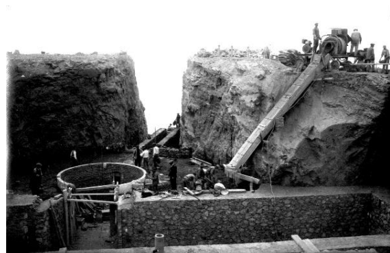
Figura 58: Vertido del hormigón en el nivel más bajo donde posteriormente se instalará el montacargas. (Fuente: Lorenzo, 2019)
