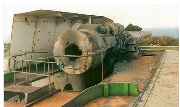
Figura 42: Interior del cañón bajo el carapacho de 7 cm de espesor. (Fuente: Rodríguez, 2014)
