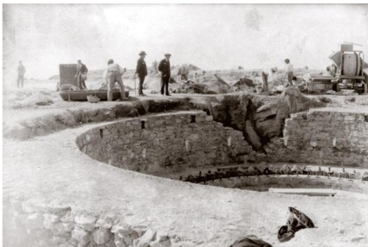
Figura 72: La construcción de los pozos se realiza a partir de cantería y relleno de hormigón. (Fuente: Lorenzo, 2019)
