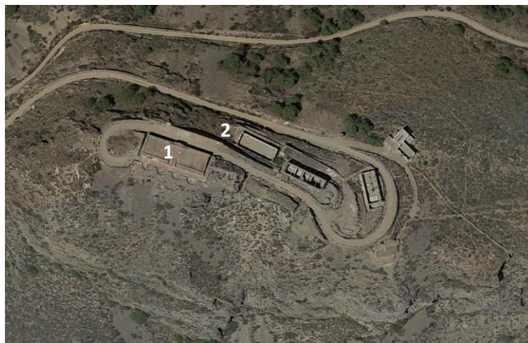
Figura 22: Foto aérea de la batería de Atalayón. A pesar de que aún se conserva el pabellón de plantones (1), así como las barbetas y edificios de repuestos (2) de las piezas de artillería, el conjunto se encuentra en mal estado de conservación. (Fuente: Captura de Google Earth. Recuperado 13/04/2020 de https://bit.ly/3hUIN8I )
