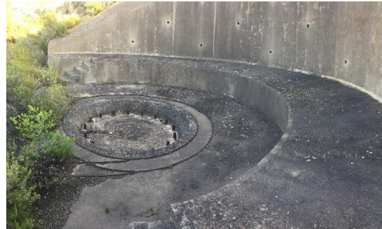
Figura 19: A pesar del mal estado de la batería, se puede observar cómo aún se conservan los raíles que facilitaban el transporte de munición. (Imagen propia)
