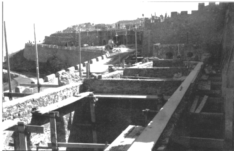
Figura 63: Construcción del edificio de taller y almacén. Al fondo de observa lo propio con la portada principal, así como el sistema de andamios. (Fuente: Lorenzo, 2019)
