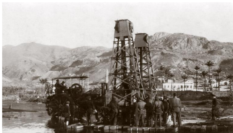
Figura 45: Construcción del muelle de La Azohía. (Fuente: Zamora, 2013)
