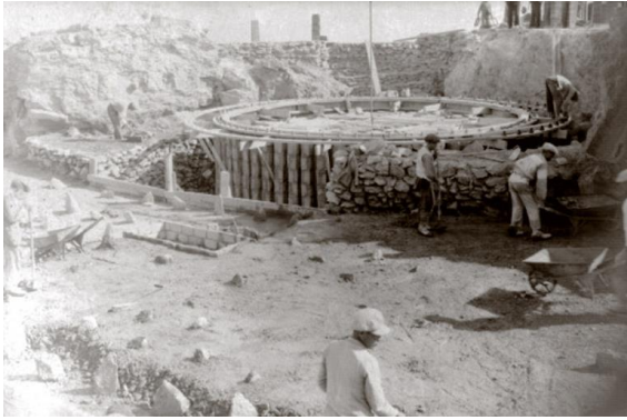
Figura 59: Instalación de elementos metálicos para la plataforma encargada de permitir el giro de las piezas de artillería. (Fuente: Lorenzo, 2019)
