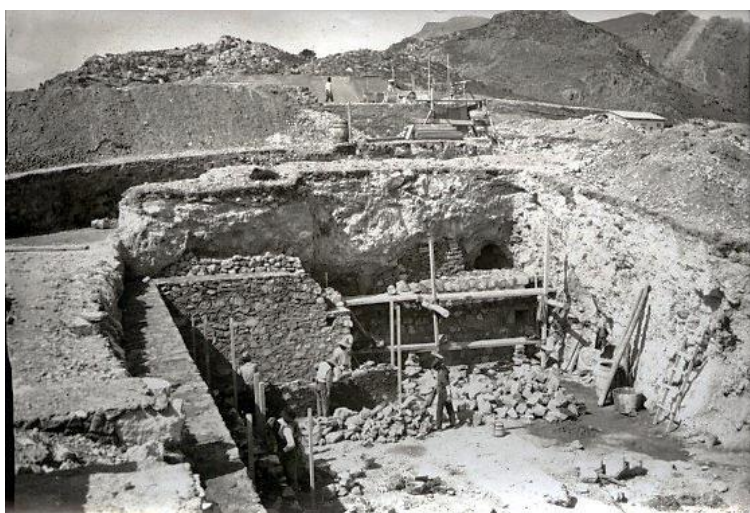
Figura 65: Construcción de locales subterráneos destinados a la dirección de tiro y fosos de las piezas de artillería. (Fuente: Lorenzo, 2019)
