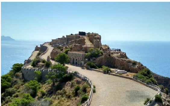
(↑) Figura 32: Edificios de repuestos nº1 y nº2. Únicamente se encuentra emplazado el cañón del edificio nº2, ya que el primero fue transportado a la costa de Almería. (Imagen propia)
