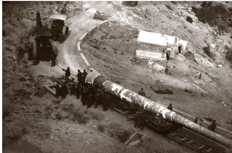
Figura 46: En la fotografía se puede observar la locomóvil tirando de uno de los cañones dispuesto sobre los raíles móviles del suelo, y que posteriormente será artillado en la batería de Cenizas. (Fuente: Zamora, 2013)
