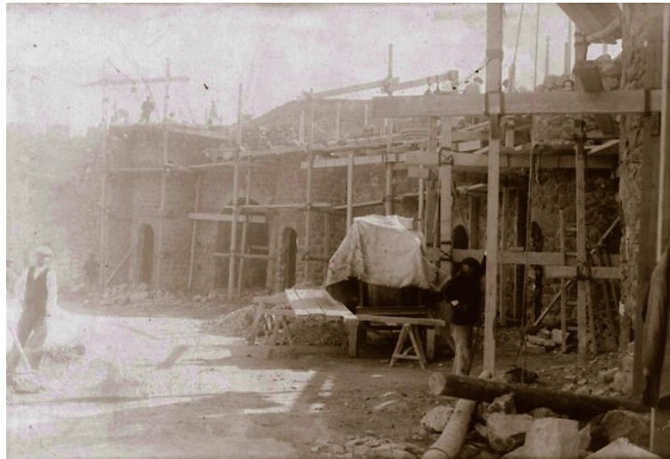
Figura 53: Construcción de la fachada principal de Castellitos. Imagen facilitada por Juan Lorenzo de la Directiva de Aforca (Fuente: Lorenzo, 2019)
