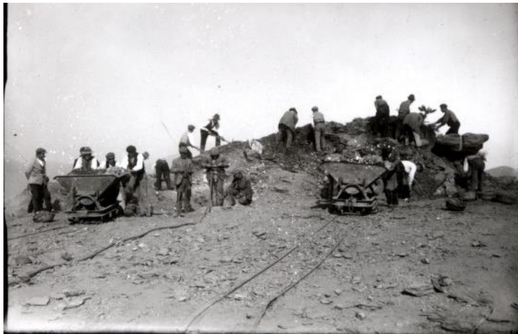
Figura 71: Obras de explanación y desmonte de la loma. (Fuente: Lorenzo, 2019)
