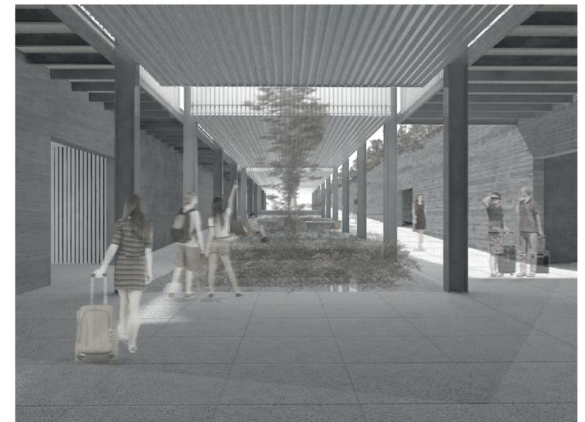
En la siguiente imagen se observa una vista interior del paso inferior de la estación de tren. Se percibe la disposición pautada de los muros de hormigón estructurales que soportan el peso de las vías del tren y el paso de vehículos ferroviarios.
