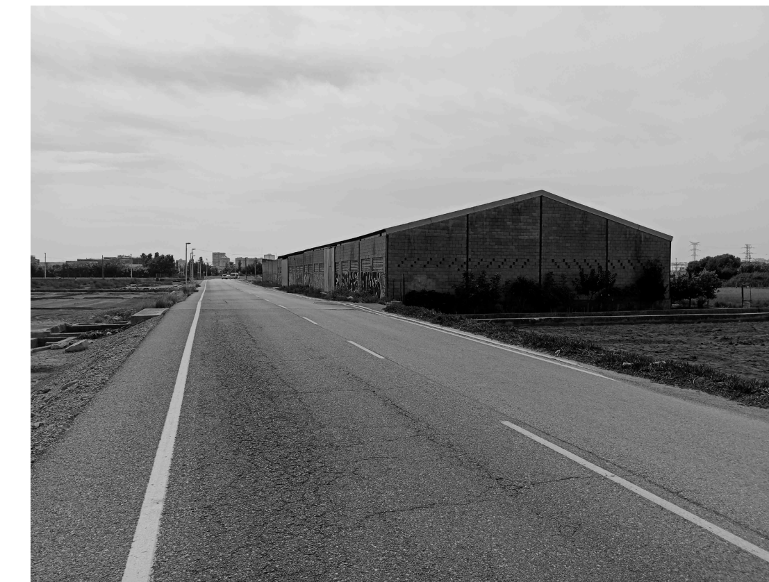
Construcción a eliminar
