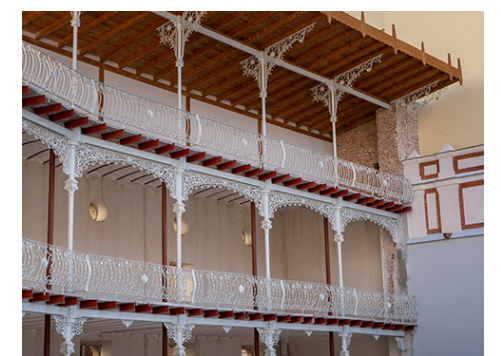
Fig. 99 Vista desde la cancha de la cerrajería del cuerpo de gradas
