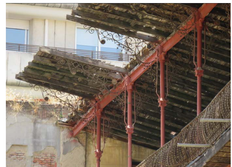
Fig. 113 Pérdida de material de cobertura y entablado de la cubierta del cuerpo de gradas
