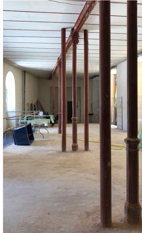
Fig. 100 Interior del cuerpo principal
