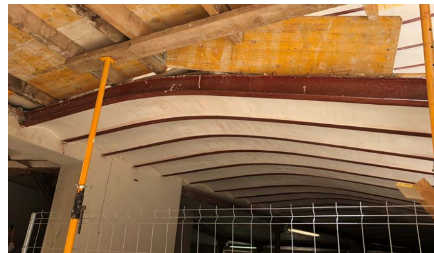
Fig. 119 Viguetas curvas recuperadas durante la rehabilitación. Revoltones enlucidos con yeso
