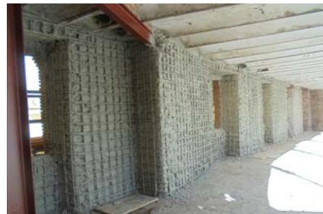
Fig. 105 Ejecución del muro forro
