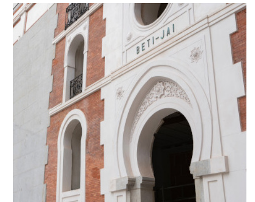
Fig. 122 Detalle de las molduras de la fachada interior tras la rehabilitación
