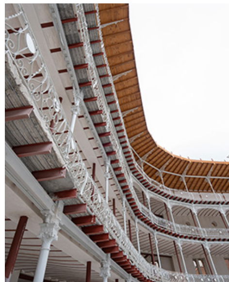
Fig. 106 Vista de los forjados
