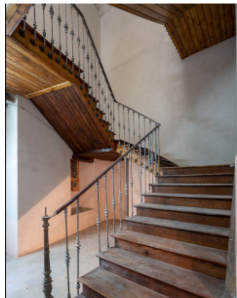
Fig. 94 Caja de escaleras del cuerpo principal
