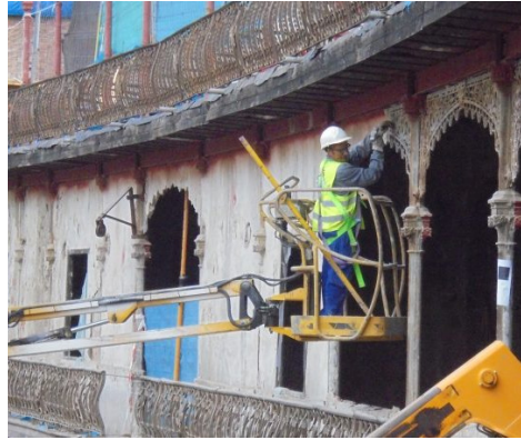
Fig. 116 Eliminación de elementos peligrosos
