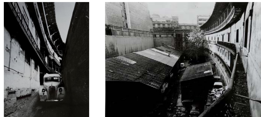
Fig. 58 y 59 Graderío tapiado y naves en el frontón Beti Jai
